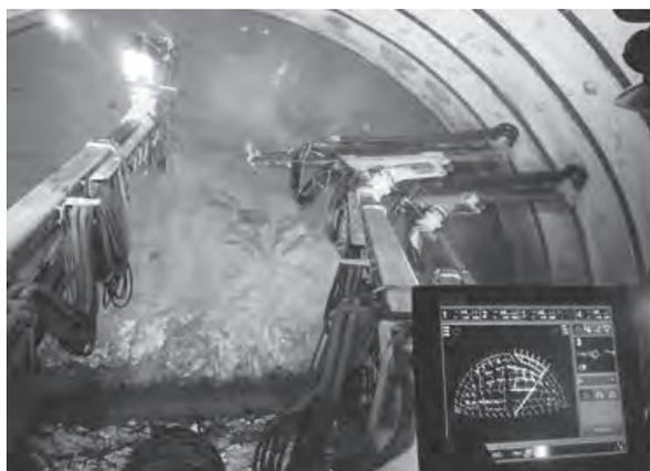
写真一 1 コンピュータジャンボによるブーム制御<sup>3)</sup>
