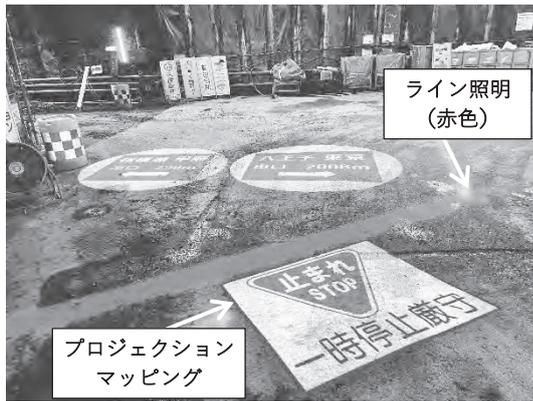
写真一4 プロジェクションマッピングとライン照明（赤色）による一時停止表示（坑内への出入口）
