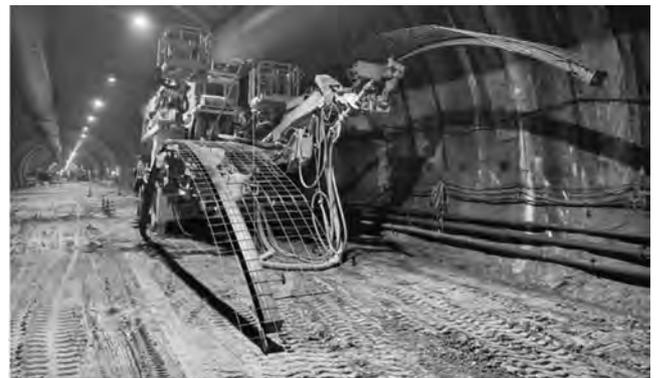
写真一 1 支保工と金網のユニット化した一例
