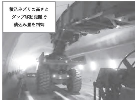
写真-3 センサによる積込み量検知状況
