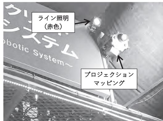
写真一6 プロジェクションマッピングとライン照明の機器の設置状況（セントル台車）
