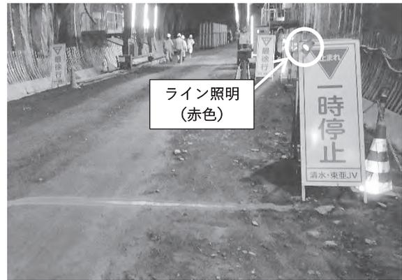
写真一7 一時停止看板にライン照明の機器を設置した事例
