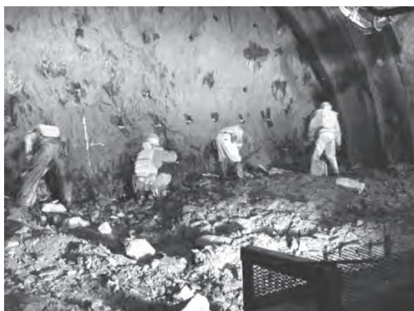
写真一 2 人力による装薬作業<sup>4)</sup>
