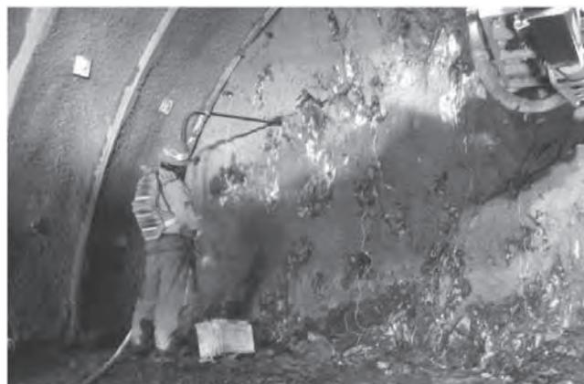
写真一 4 爆薬の遠隔装填<sup>4)</sup>
