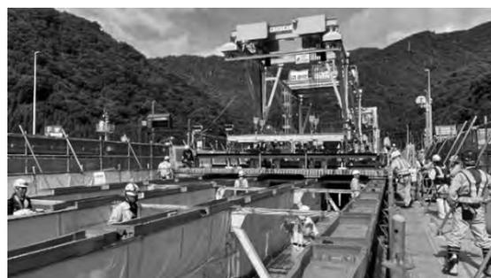
写真-1 SDRシステムの施工状況 (阿能川橋)
