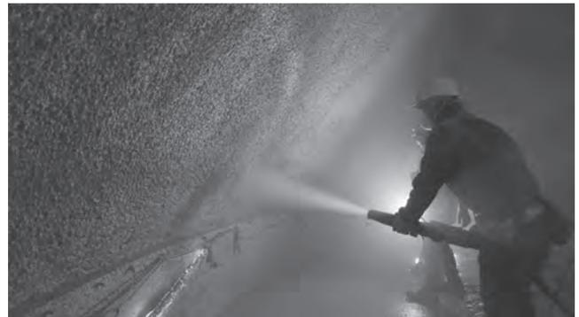
写真一3 吹き付けコンクリートによる躯体の構築
