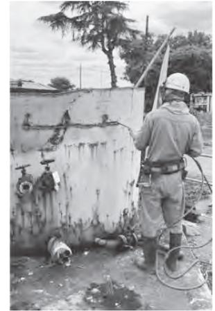
写真-5 水タンクの解体作業
