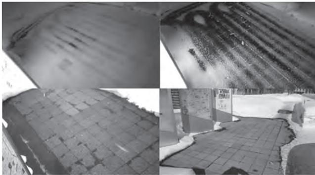
写真一3 循環・ヒートポンプ併用式システム 融雪状況
