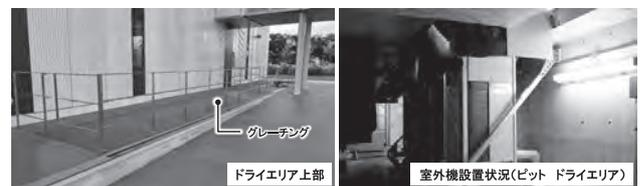
図一九 免震ピットへの室外機設置状況
