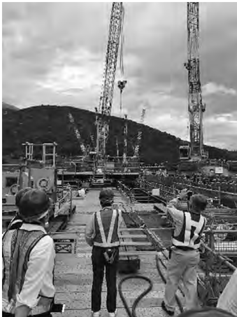
写真—9 運搬台車とトラバークレーン
