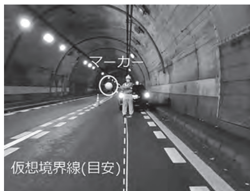
(c) 供用トンネル撮影画像
