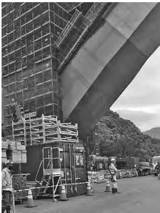
写真—5 外鋼殻構造部
