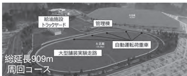
図ー15 次世代舗装実験走路
