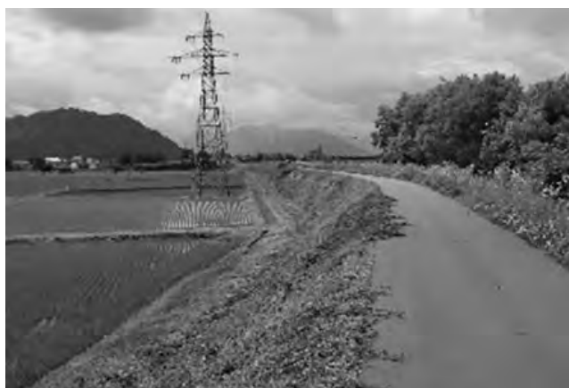
写真—1 急傾斜法面の例
