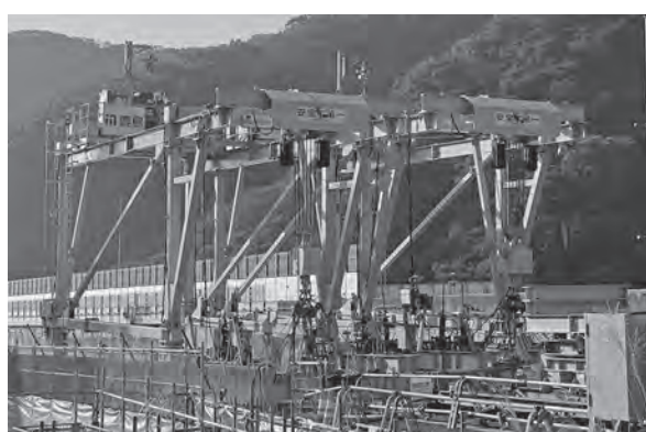
写真—2 既設床版の撤去機
