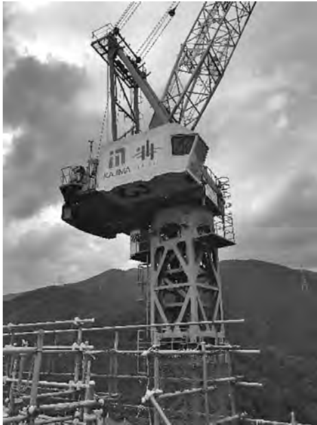
写真—8 タワークレーン
