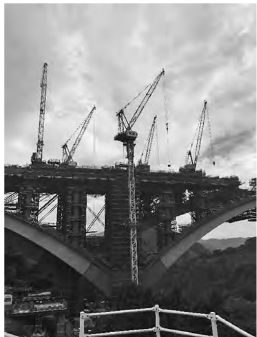
写真—4 アーチ根本のスプリング部：外鋼殻構造
