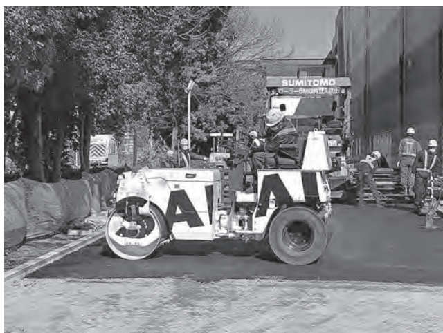
写真—1 フル電動式4トンコンバインドローラの施工状況
