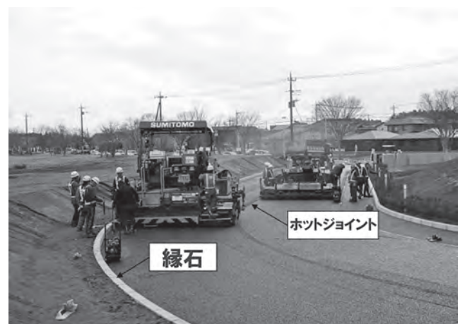
写真—4 試験施工③
