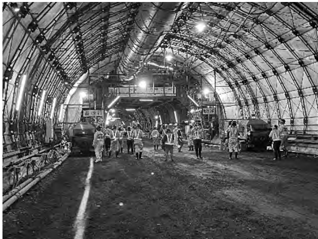
写真-7 セントル全景
