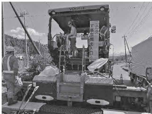
写真—9 現場における遠隔操作状況
