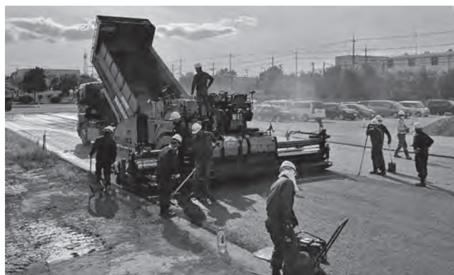
写真—1 舗装現場
