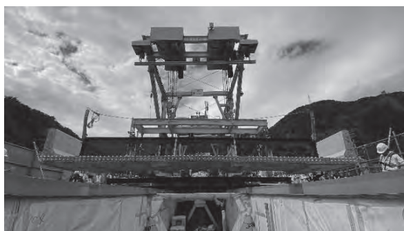
写真—6 新設床版の架設状況（阿能川橋）
