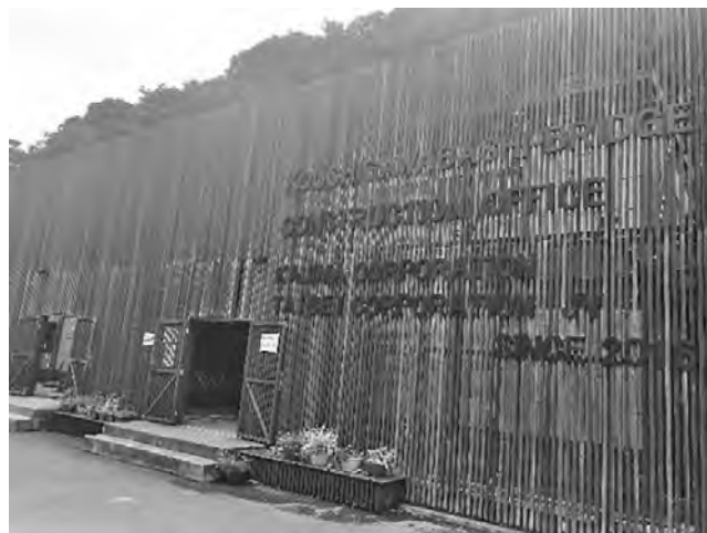
写真—6 現場事務所外観
