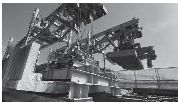
写真—7 既設床版の撤去状況（奥畑川橋）
