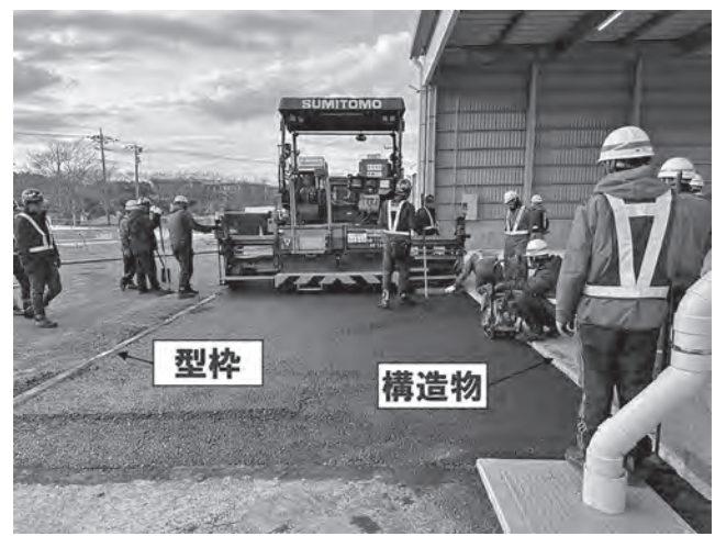
写真—3 試験施工②
