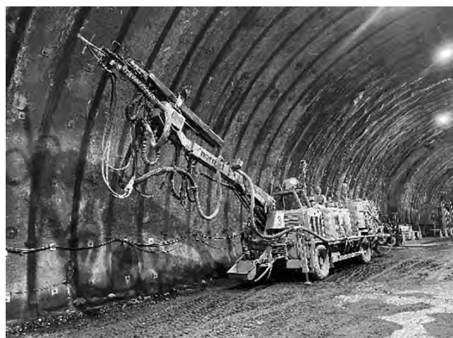
写真—6 3D スキャナ搭載吹付機（NORMET 社製）
