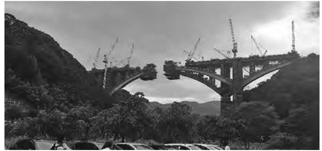
写真—2 近づく中央径間の移動作業車
