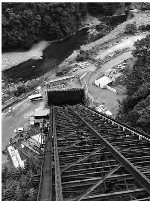
写真—1 インクラインに乗って下を見た状況
