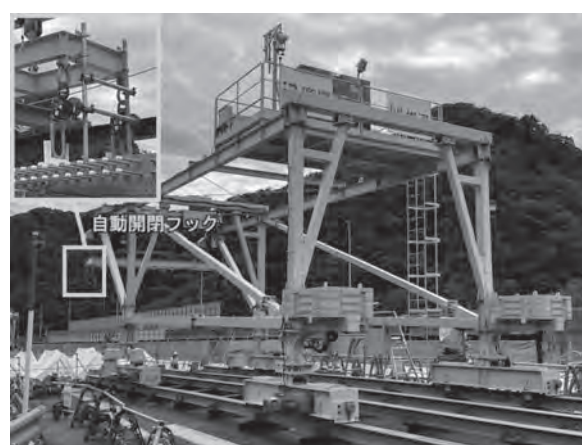
写真—3 新設床版の架設機
