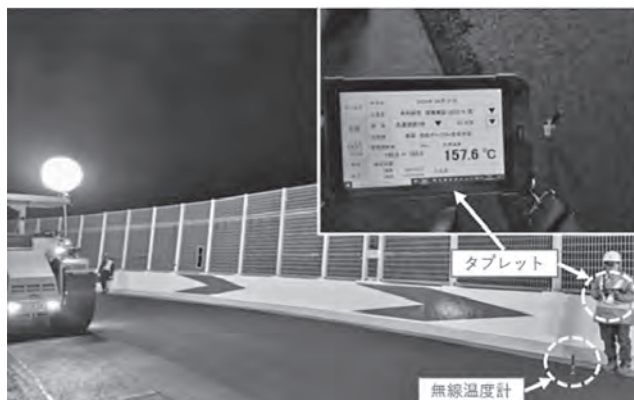
図ー5 転圧温度計測状況
