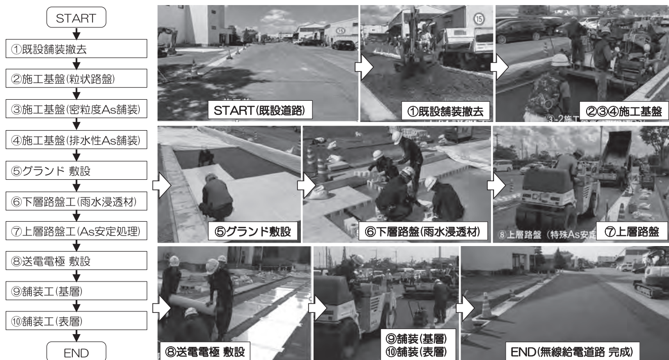
写真－7 無線給電道路の施工方法・作業フロー
