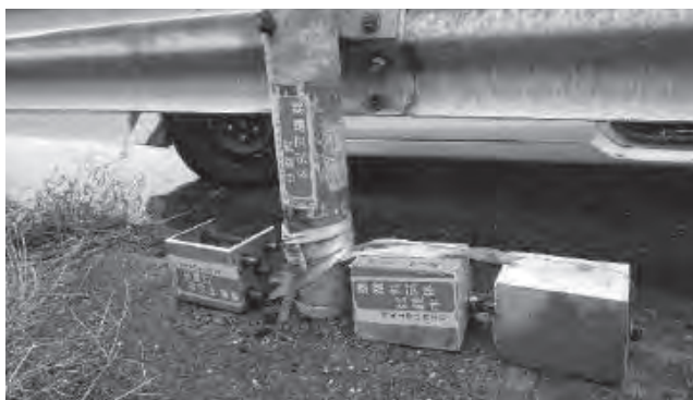
写真-4 暴露試験供試体設置状況
