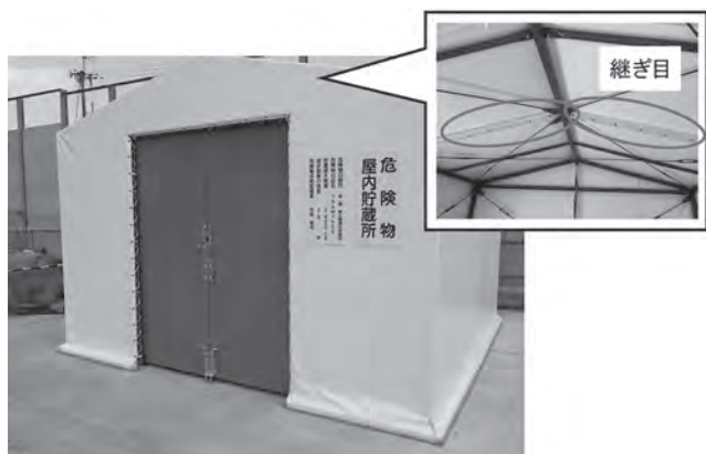
写真—4 危険物屋内貯蔵所の例
