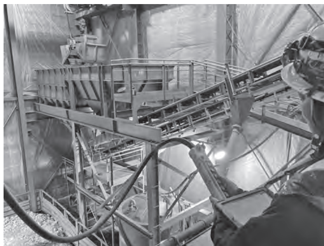
写真—3 タブレットを確認しながらの材料供給作業状況
