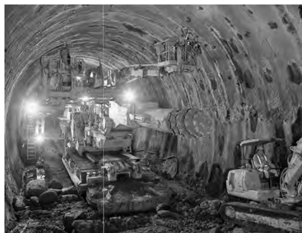
写真－1 ガントリージャンボと自由断面掘削機
