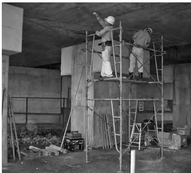
写真—1 近接目視によるコンクリート構造物のひび割れ点検状況
