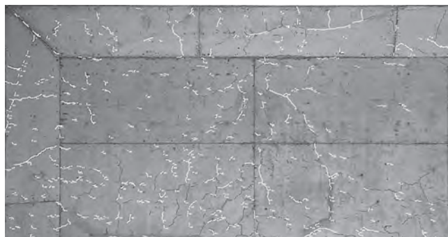
図一 4 高架橋床版下面のひび割れ図
