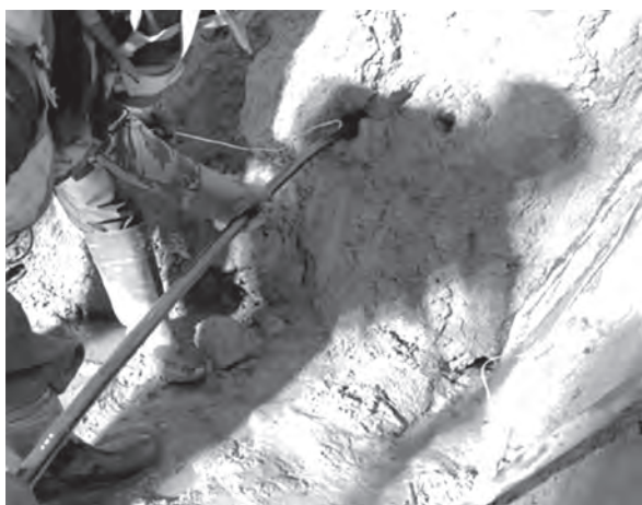
写真一 爆薬装填状況
