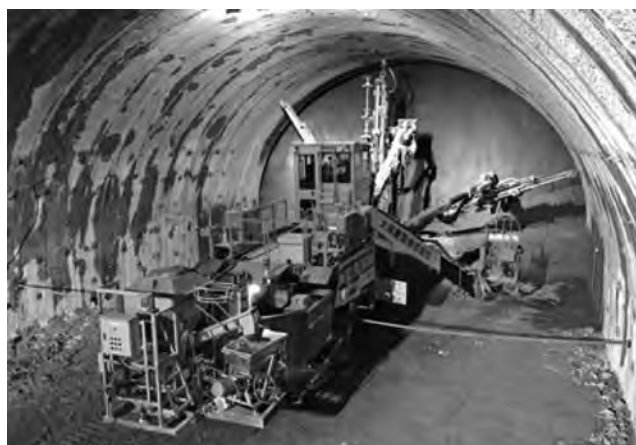
写真一 4 6 m 継ぎボルト打設装置を搭載したロックボルト専用ロボット「BOLTINGER」
