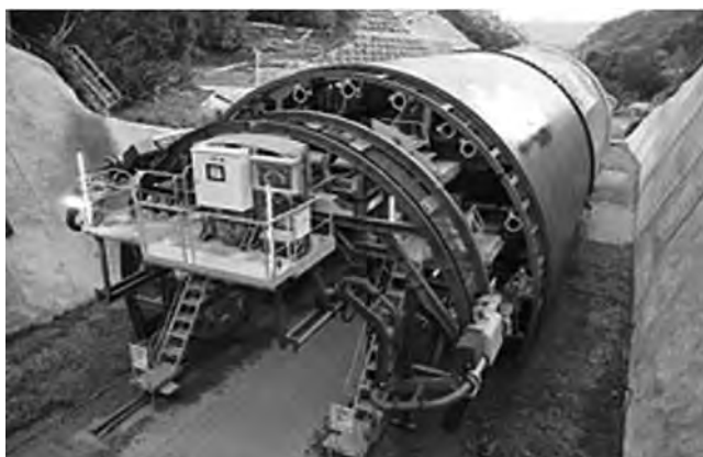
写真一 3 トンネル覆工コンクリート自動施工ロボットシステム
