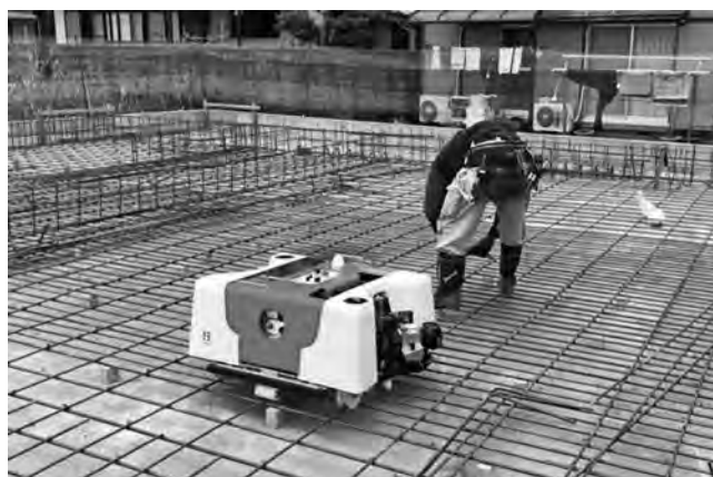
写真—6 鉄筋結束ロボット「トモロボ」
