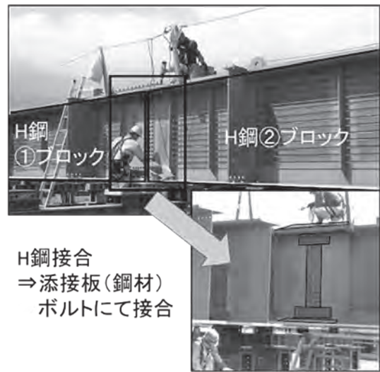
図-7 添接板を使用した現場接合
