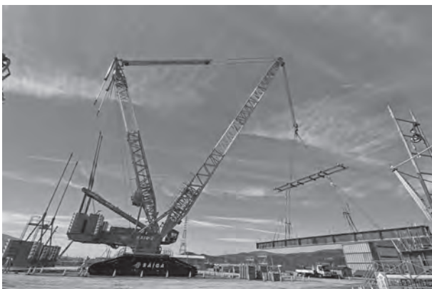
写真-1 大型クレーンによる架設の様子
