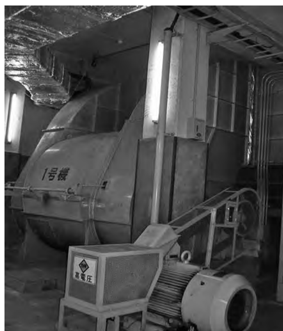
写真—1 換気機の設置状況
