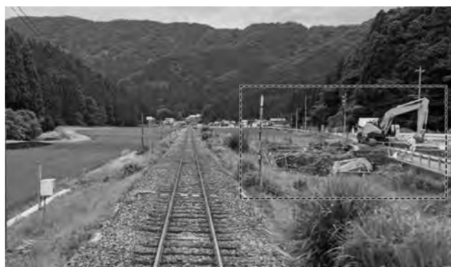
写真一6 近接工事の発見例
