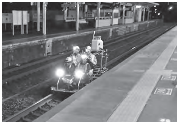
写真二 計測状況
