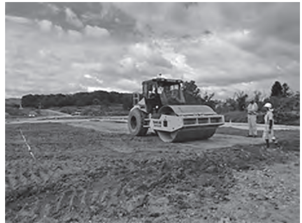
写真—2 倶知安保守基地におけるICT土工の試験
