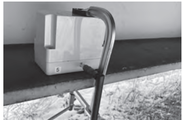
写真-1 センサユニットの橋桁への設置
