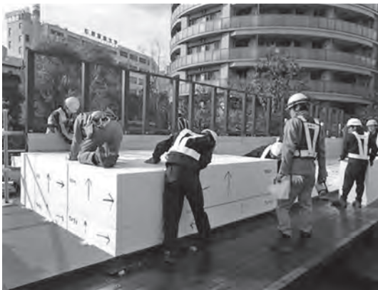
写真-1 EPS ホーム組立試験
