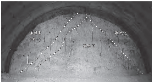
図一 11 本坑の切羽写真 (206 km 838.9 m)
