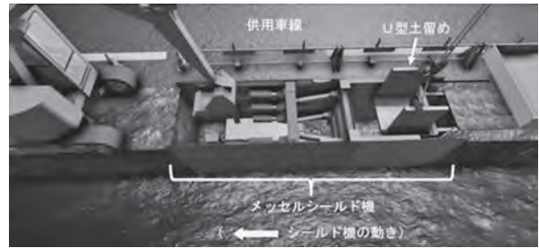
図-2 クイック re インバートの概要図
