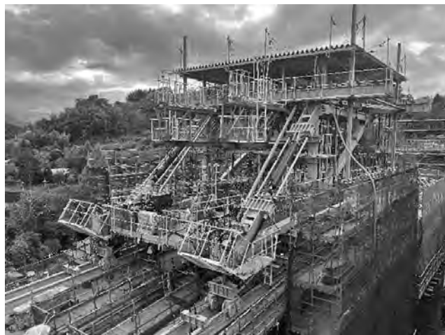
写真—4 アーチリブ移動作業車（斜め後方から）
