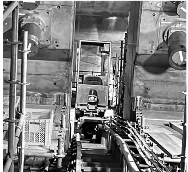
写真—7 緊張ジャッキ運搬台車
