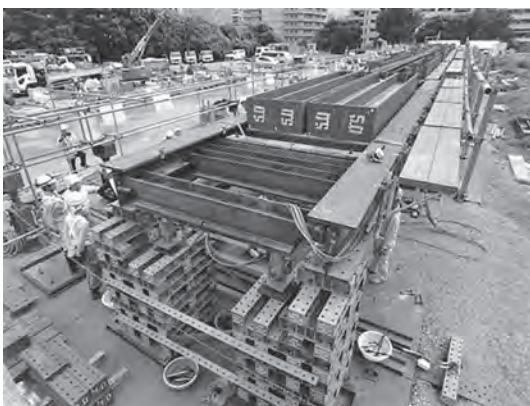
写真-2 工事桁扛上、横移動試験
