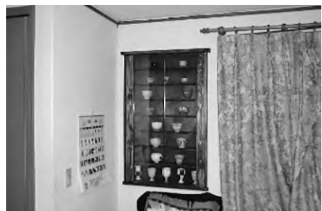
写真—3 壁をくり抜いて設置した食器棚
