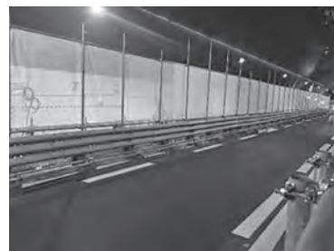
図-3 仮設防護柵設置状況
