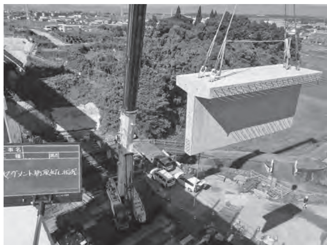
写真—3 プレキャストによる橋梁工事
