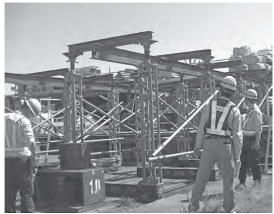
写真-3 ホーム横桁架設試験
