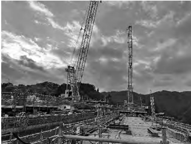
写真—5 トラベラークレーン
