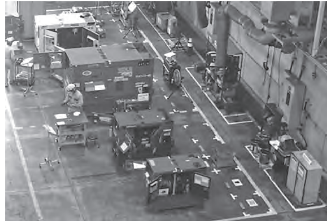
写真—3 整備中の発電機
