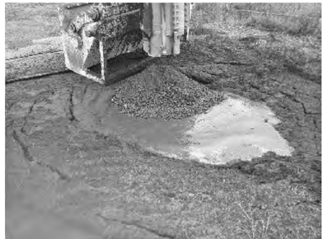
写真-2 改良後の地表面の状況
