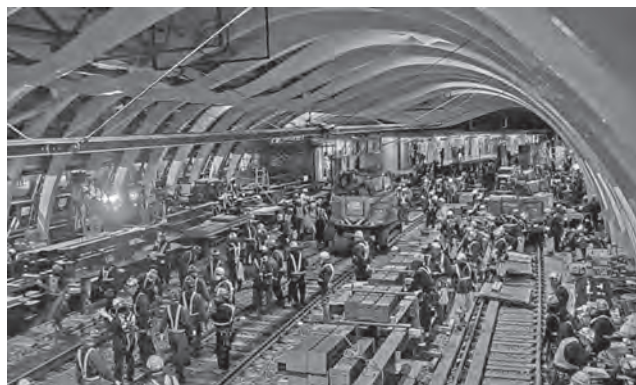
写真-1 渋谷駅移設切替工事実施状況
