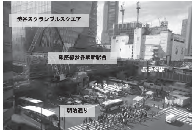
図—5 渋谷駅東口周辺の狭隘な施工空間
