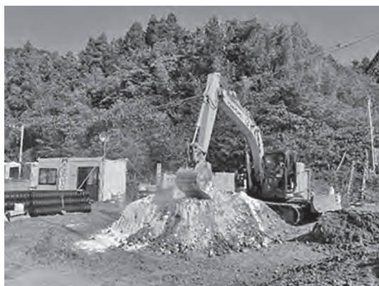
写真一 1 低炭素型土質改良材 C の使用状況
