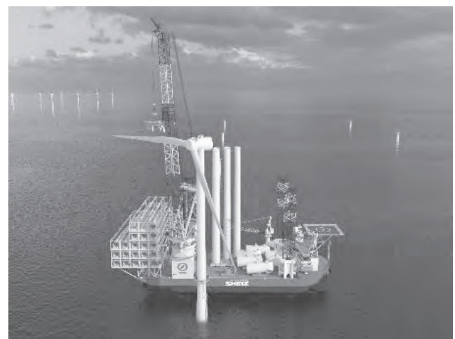
図-5 風車施工イメージ (エクステンデッドモード)
