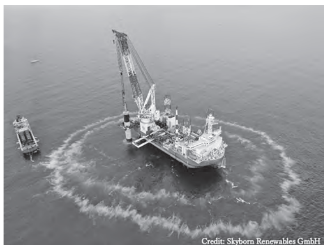
写真—11 Yunlin Offshore Wind Farm 風車基礎打設
