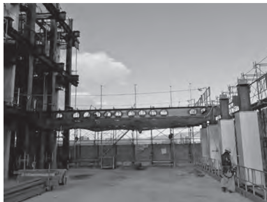
写真一3 耐火集成材柱の養生
