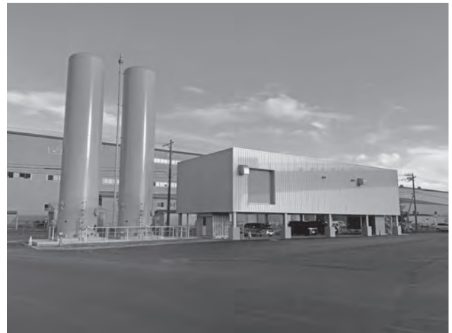
写真—3 水素棟外観
