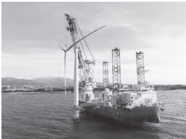
写真—9 入善沖洋上風力 風車据付
