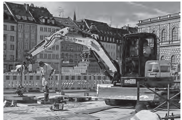
写真一40 ミュンヘン中心部での改修作業（アタッチメントでブロックを設置している作業員）
