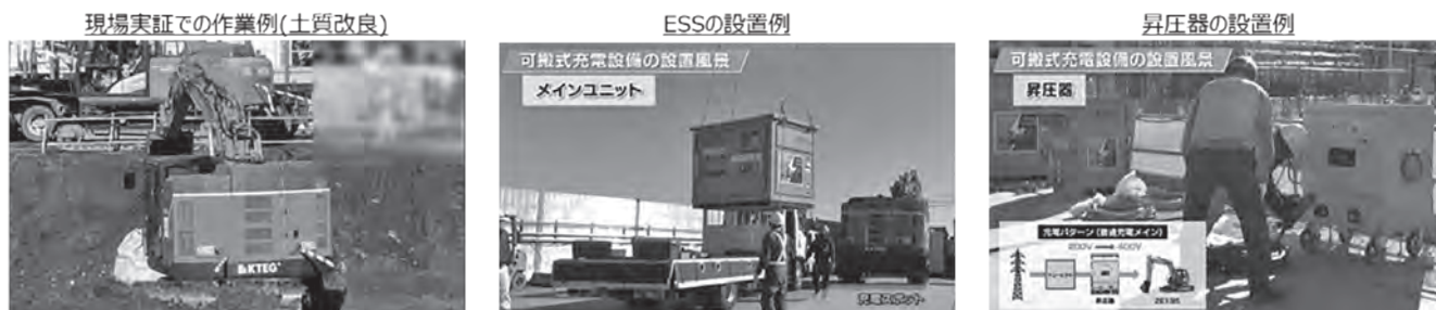
図一五 現場実証を通じた電動建機および周辺設備の実例
