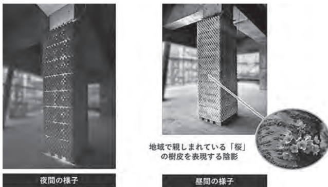
図一六 柱仕上材に3Dプリンタで成形した Carbon-Recycle
