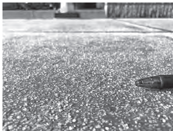
写真一1 路面太陽光パネルの凹凸加工
