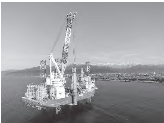
写真—8 入善沖洋上風力 風車基礎打設
