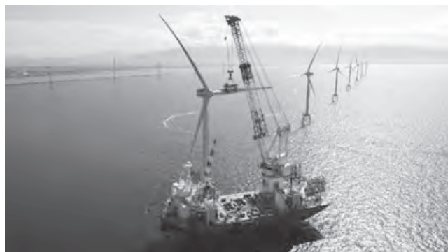
写真—10 石狩湾新港洋上風力 風車据付
