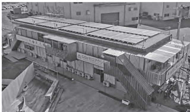
写真—4 仮設事務所全景
