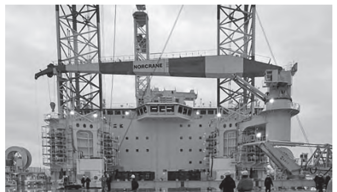
写真-2 30 トン吊 補助クレーン (Aux Crane)
