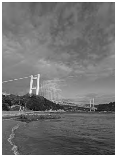
写真一九 下津井瀬戸大橋
