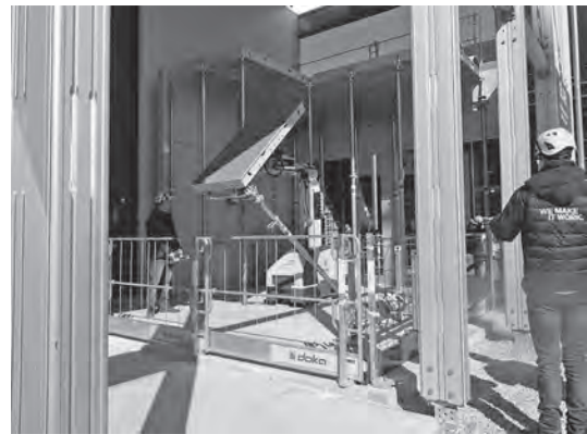
写真—30 作業床を自動で配置するロボット
