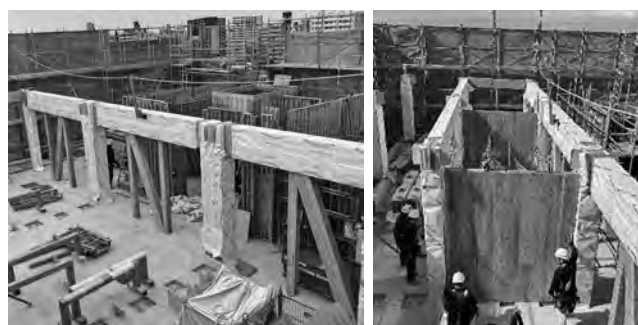
<柱・梁部材> <CLT耐震壁>
