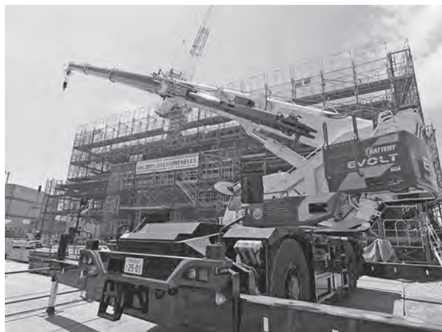
写真一 3 (株)タダノ製 25t電動ラフタークレーン
