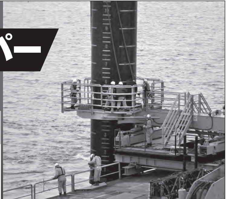
洋上風力発電ジャケット基礎杭工事
