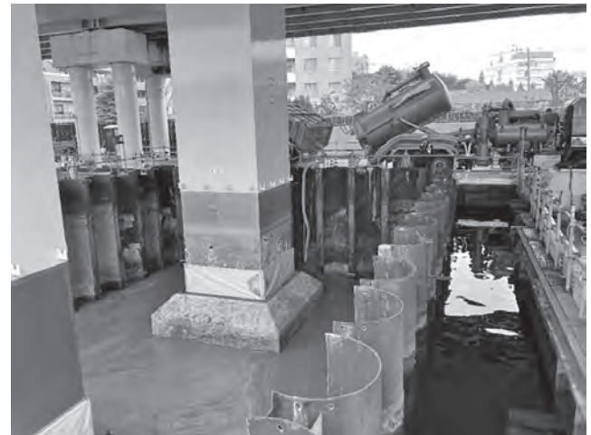
写真一 二 流動化処理土用途での施工状況
