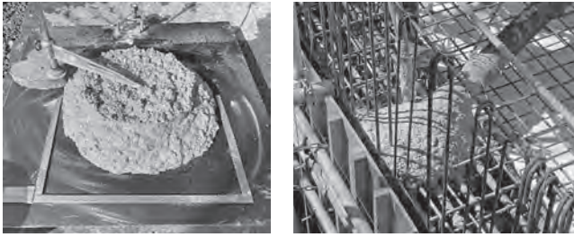
写真一七 CELBICのスランプ試験と打設状況
