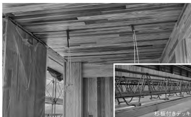
写真—5 杉板付きデッキ材を使用した天井面
