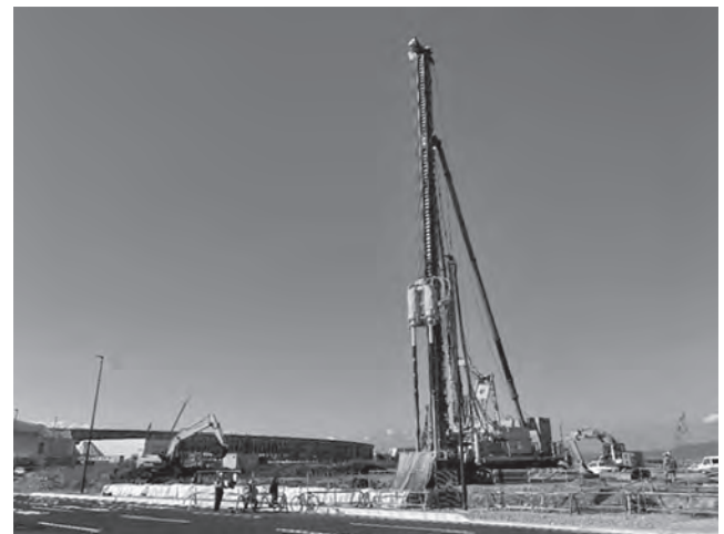
写真一 三 機械攪拌工法用途での施工状況
