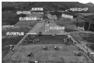
写真—1 堤体全景と材料運搬システム
