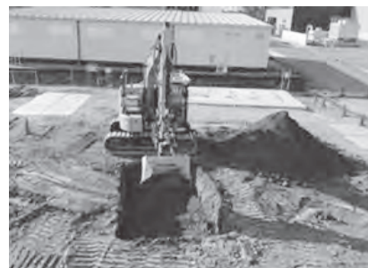
写真—1 実証実験状況
