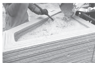
重力式擁壁（構造部材型）
