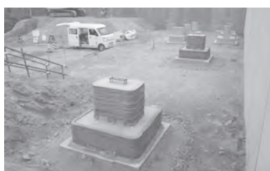
配管サポート基礎の型枠（非構造部材型）
