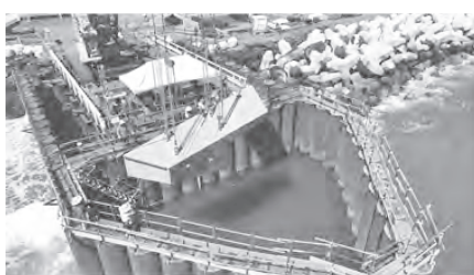
岩盤型潜水突堤（構造部材型）
