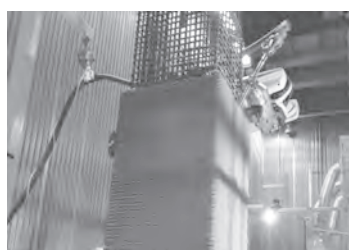
大型新設柱（構造部材型）
