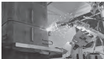
自動溶接中の状況
