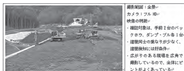
図—6 工事全景撮影の例
