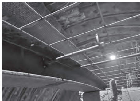
写真一2 金網・頭付きアンカー
