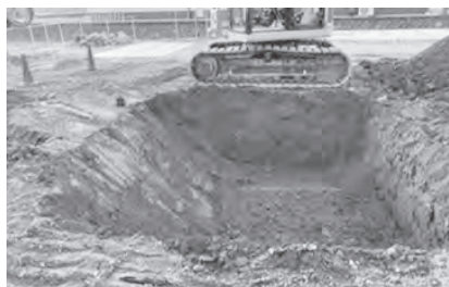
写真一三 自動掘削による出来形（ケース 1）
