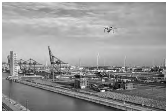
写真—1 ベルギーアントワープ港における空中ドローンによる日常管理・監視事例 1)
