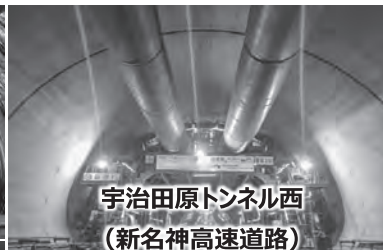
宇治田原トンネル西打設状況
