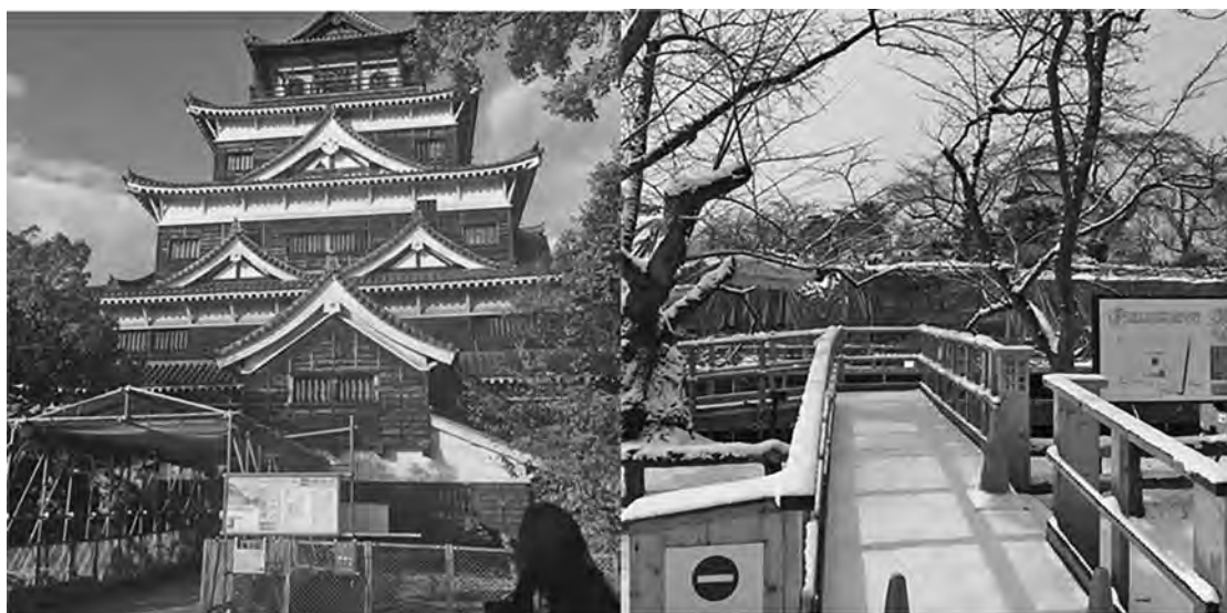
写真—3 修復工事中的お城（左：広島城 右：弘前城）
