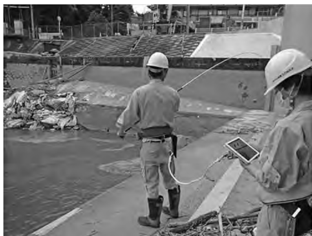
写真—4 パイピング調査手法（音響探査）
