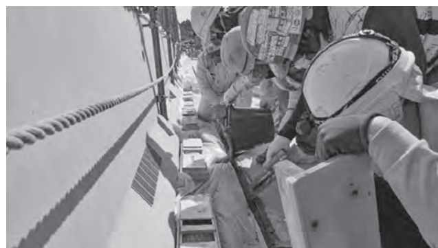
写真ー7 縦目地への VFC の充填
