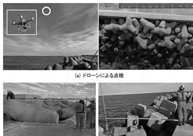
写真—3 消波ブロックの点検状況
