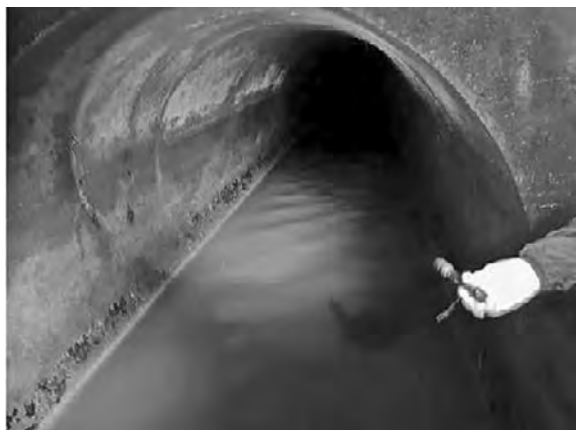
写真一 2 下水道管路の緊急点検の様子
