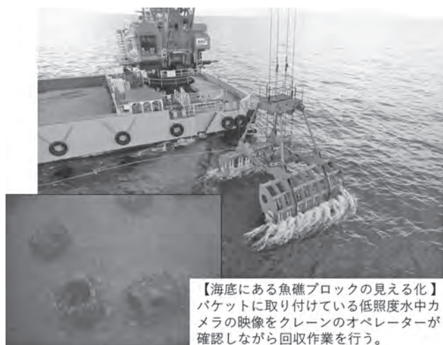
写真—2 特殊バケットを用いた移設作業
