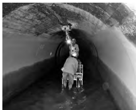
写真—10 管路内における管路背面の地盤の空洞調査例
