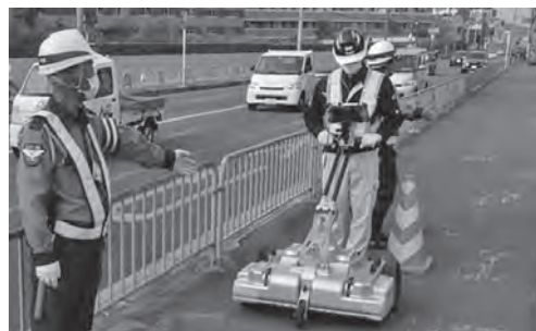
図一 6 面的探査 現地調査状況例
