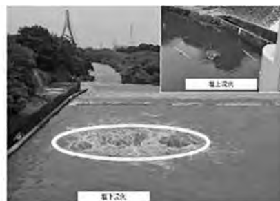
浸透破壊によるパイピング
