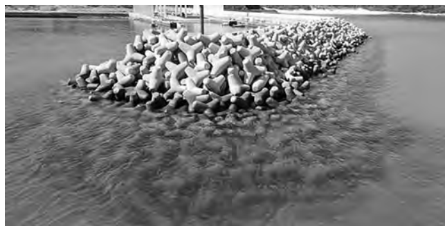
写真—1 消波ブロックを用いた防波堤
