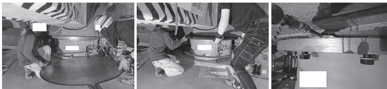
写真—3 超薄板ジャッキ設置作業状況
