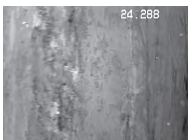
写真—4 洗浄前ストレーナ状況
