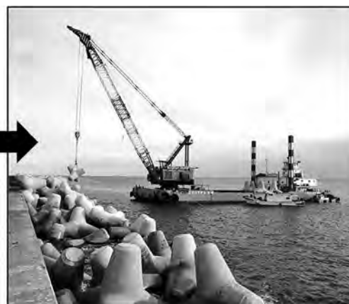
図-7 ブロック据付ARガイダンスシステム 5)
