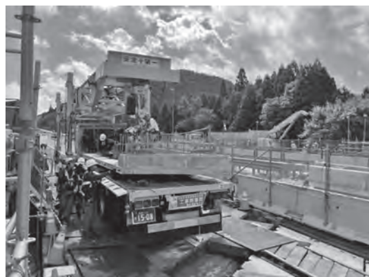
写真—2 UFC床版の荷降し
