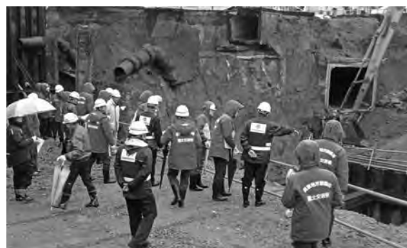
写真一 6 八潮市陥没現場の視察の様子
