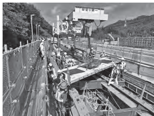
写真—4 UFC床版上の設置
