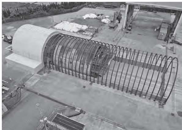
写真—3 模擬トンネル（平面線形 R=800 m, L=30 m）
