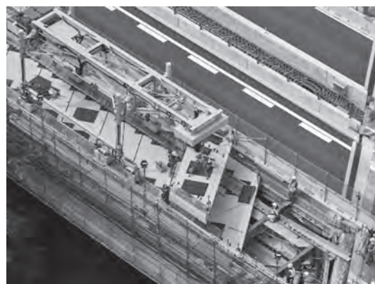
写真—3 UFC床版の運搬
