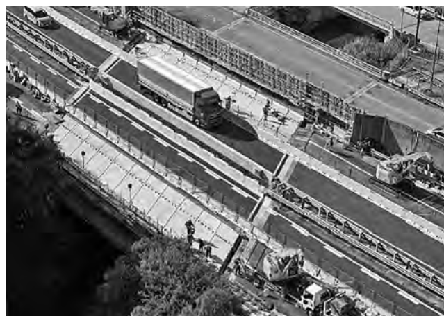
写真—1 走行車線を工事中の河内橋
