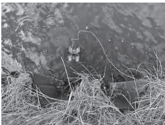
写真—7 水中ドローンによる鋼矢板調査状況
