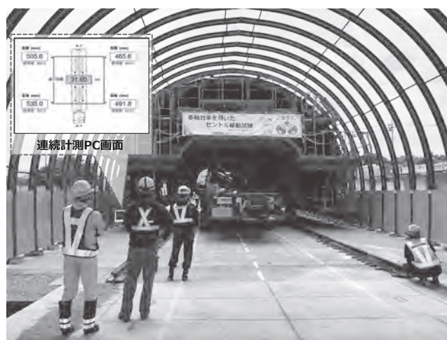
写真—2 実大セントル輸送実験
