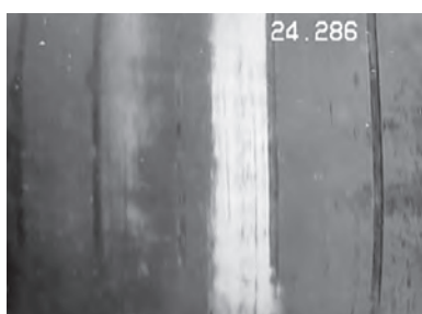
写真—5 洗浄後ストレーナ状況
