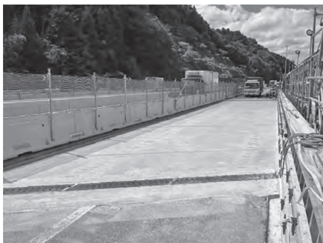
写真—10 架設後の UFC 床版
