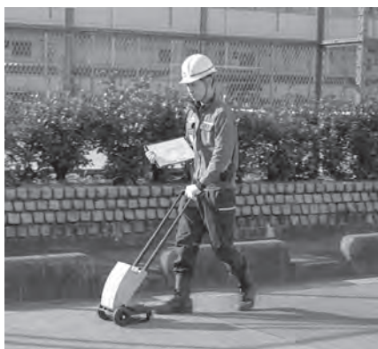
写真—1 カートタイプの半導体式検知器を用いた検査の様子
