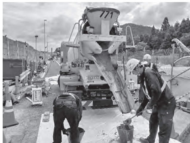
写真ー6 小型トラックアジテータからの排出
