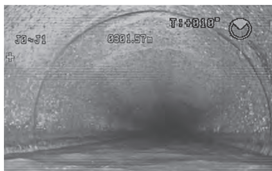
写真—8 〔調査事例2〕船体式テレビカメラ調査の様子と確認した異状箇所（管路内面の腐食あり）
