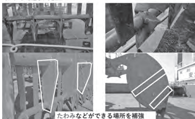
写真一 8 補強箇所
