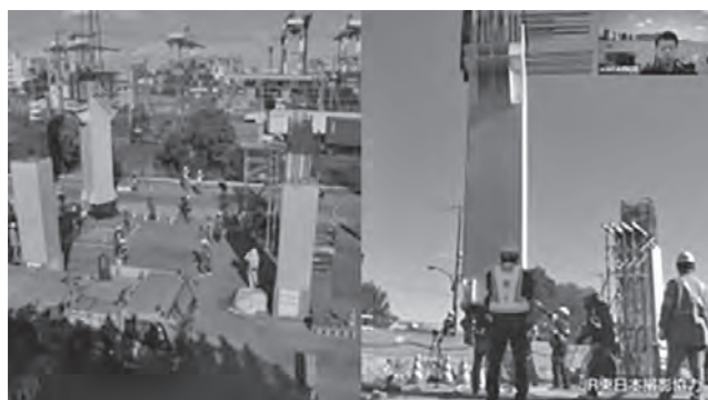
写真—3 建設会社提供動画（鉄建建設株）
