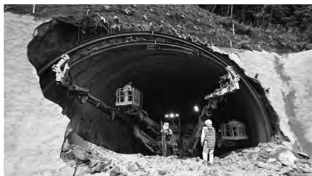
図-21 開発技術による斜坑門施工状況
