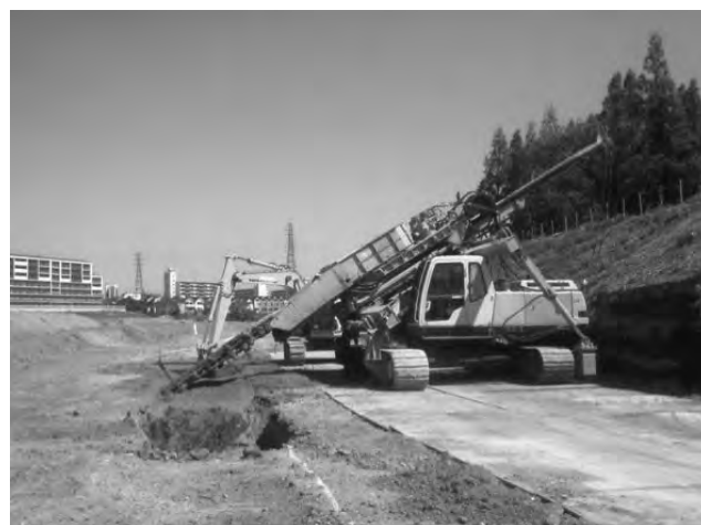
写真一 1 地中控え護岸壁施工時の TRDⅠ型*
