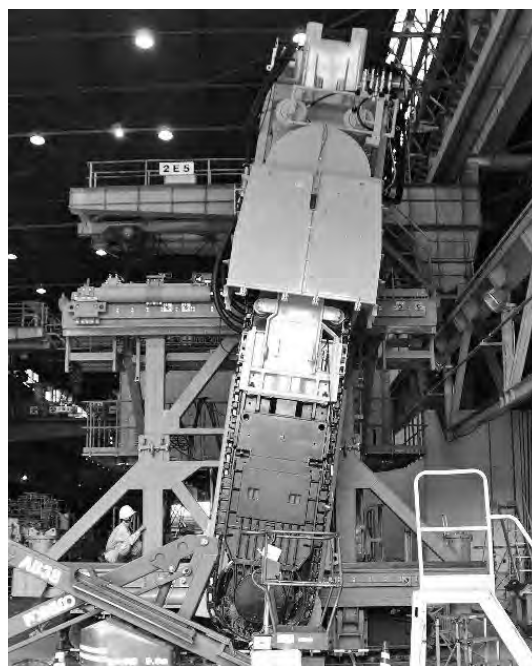
写真—5 掘進機構8度傾斜出荷試験状況
