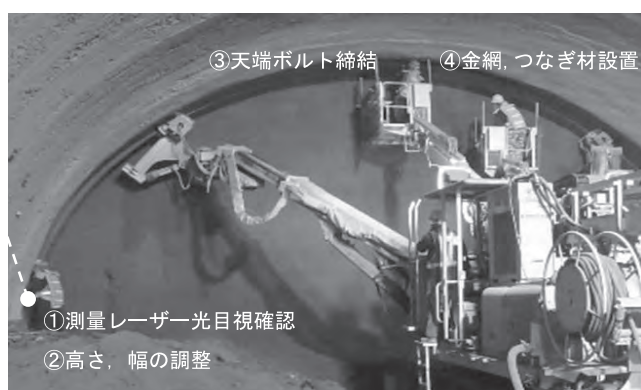
図-3 標準的な設計、施工方法 4) に基づいた支保工建込作業状況（上半）
