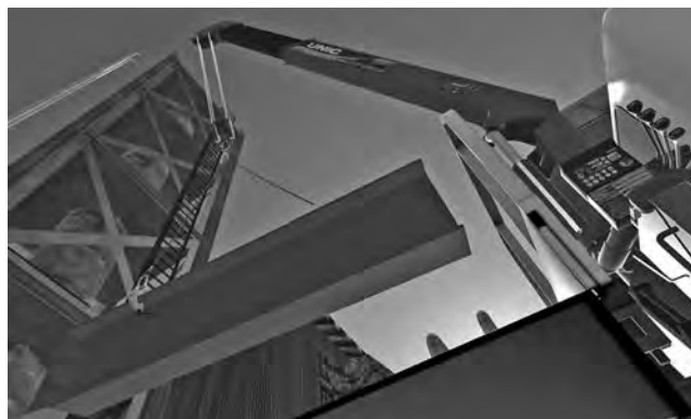
写真—7 VR 内クレーン転倒事故の本人目線の様子
