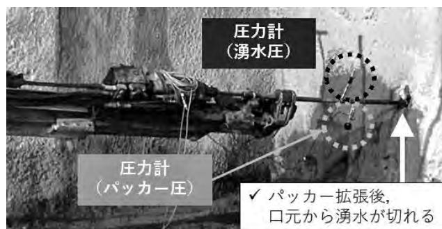
写真一 2 湧水圧測定状況
