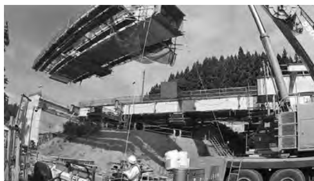
図－7 国交省発注の橋梁上部工架設現場
