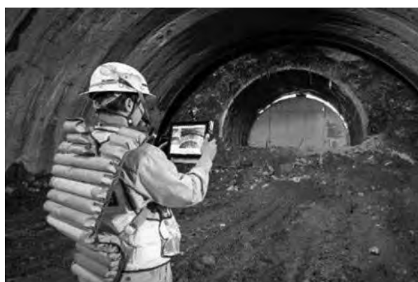
図一 8 遠隔臨場実証のようす（現場配信側）
