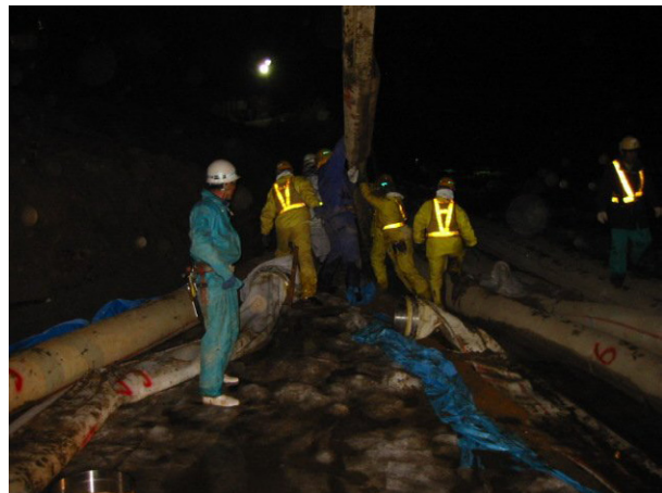
写真－6 排水ホース移設作業状況
