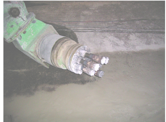
写真-1 コンクリートハツリ機
