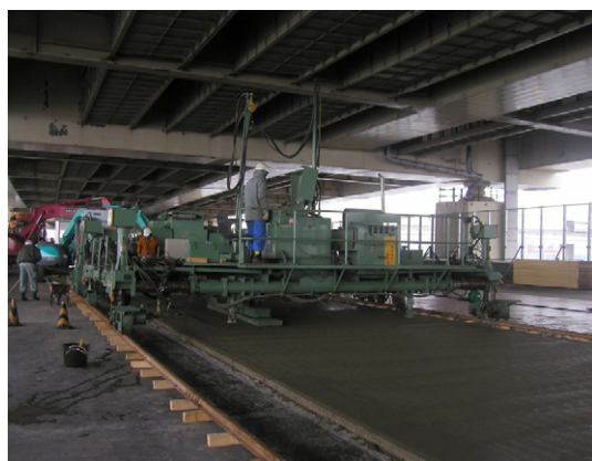
写真－8 縦仕上げ機
