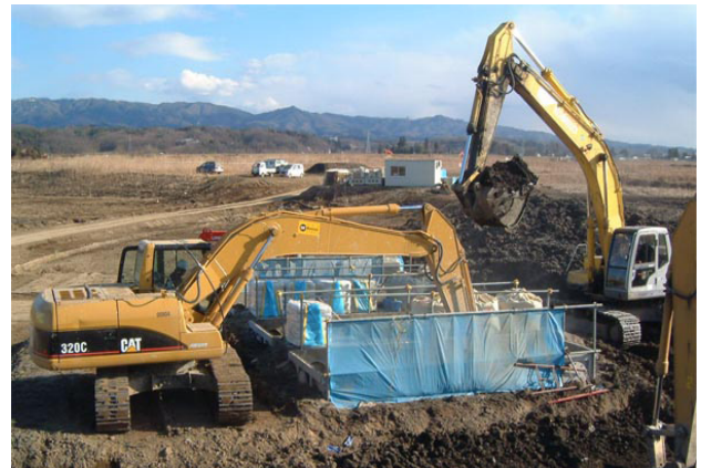
図12 浜尾遊水地における施工の様子(写真右のバックホウで高含水比原泥を掘削し、ピットに原泥を入れている。写真左のバックホウがミキサーを装着し、攪拌している。)
