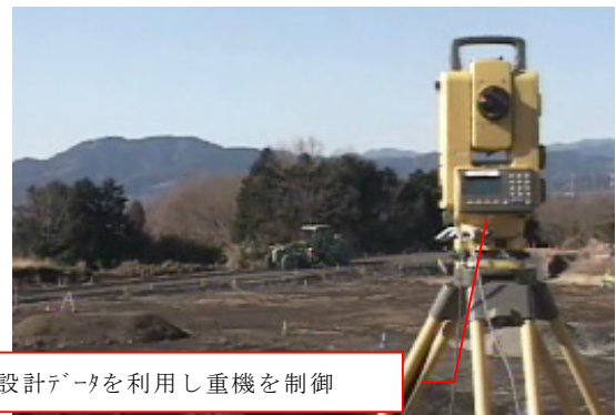
写真-2 路盤整形後の状況
