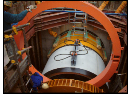
⑨ 押輪投入・組立
