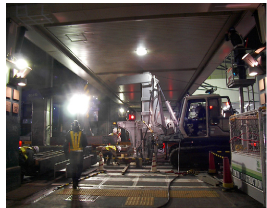
写真－5 芯材建込状況
