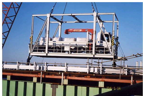
写真-3 300 t クレーン、専用ケージによる搬入
