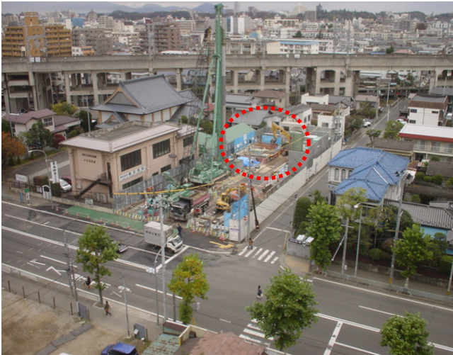
図 13 仙台東部共同溝工事現場の全景
