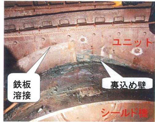
図一 12. 裏込め充填及び止水鉄板溶接
