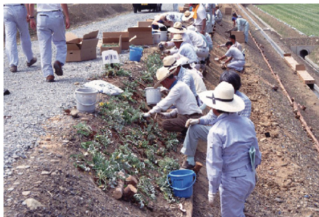
写真-1 人力によるGCPの植栽状況
