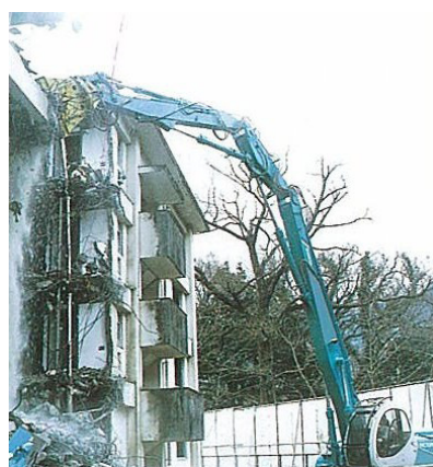
図-3：超ロング機による解体作業
