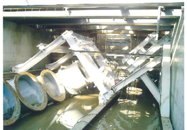
写真-2 エントランス、下部架台
