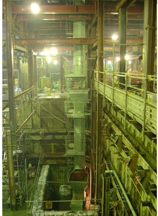
写真－3 装置設置状況
