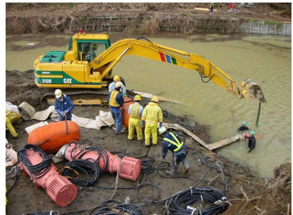
写真-9 排水ポンプの投入状況
