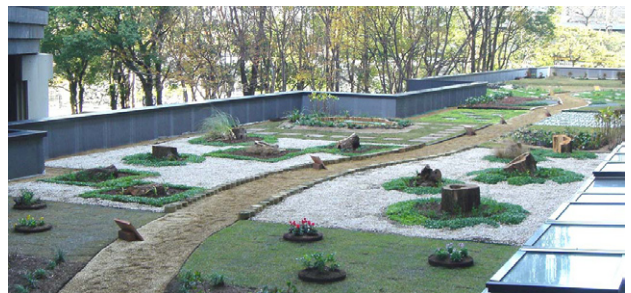
図 14 屋上緑化の一例(大分市役所本庁舎屋上緑化)
