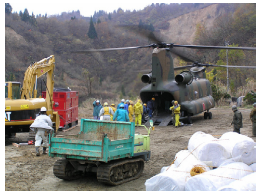
写真-1 自衛隊大型ヘリで輸送されたミニクレーンと組立が完了し稼働中の油圧ショベル
