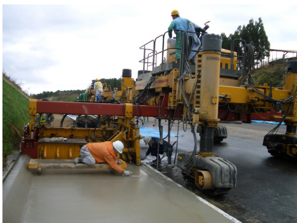
写真-2 ニツ山工事の施工状況
