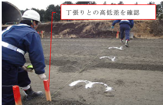
写真-1 現行路盤整形作業時の確認作業
