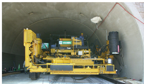
写真-7 改良型装置外観
