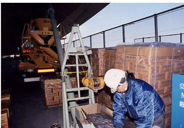
写真-1 スチールファイバ投入
