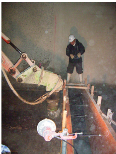
写真—7 型枠際の施工
