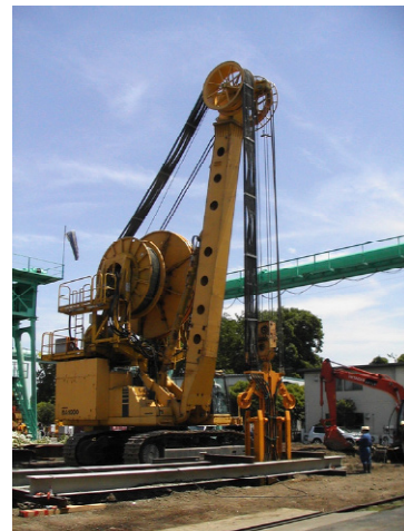
写真-2：施工状況
