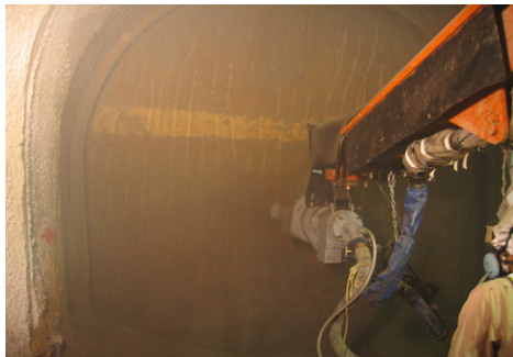
写真-5 吹付け状況 (遠心力吹付け方式)
