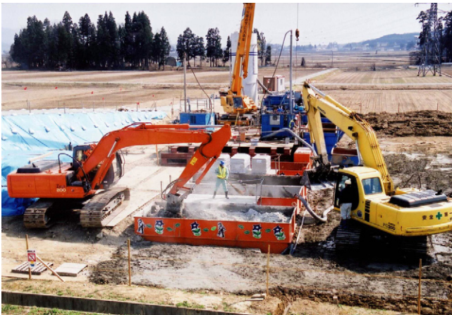
図11 繊維質固化処理土工法における施工の様子(左のバックホウがミキサーを装着し攪拌している。右のバックホウは、出来上がった処理土を脇に仮置きする。)
