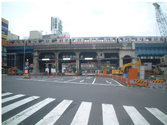
写真－1 施工箇所
