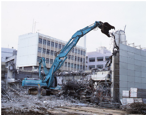
図-10：セパレートアタッチによる解体作業
