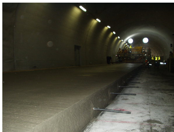
写真-8 瀬野川トンネル施工状況
