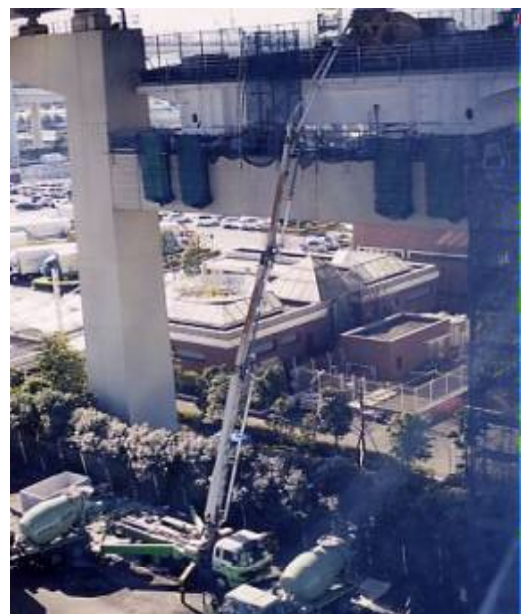
写真-6 ポンプ車による圧送
