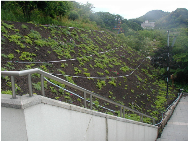
写真-4 吹付2ヶ月後
