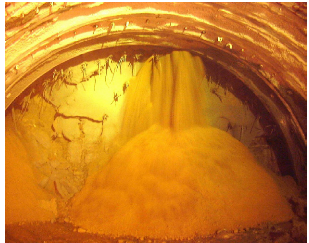
写真-1 NATM 施工における切羽崩落状況
