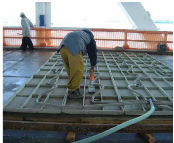
写真-2 真空脱水工法
