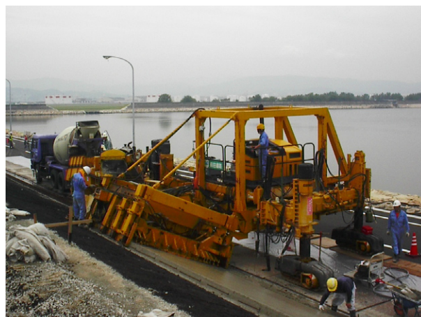
写真-3 岩国工事の施工状況
