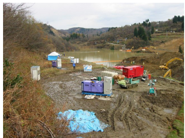
写真-4 田畑に点在した制御盤・発動・燃料缶
