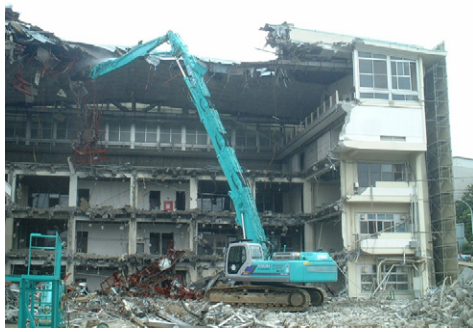
図-9：超ロングアタッチによる解体作業
