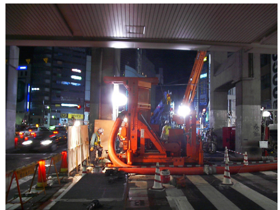
写真－2 TBH機削孔機
