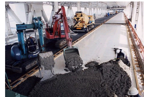
写真-5 ⑥受取 ⑦撒き出し ⑧粗均し
