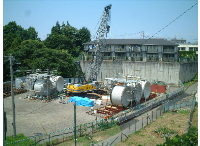
写真-6 発進基地全景
