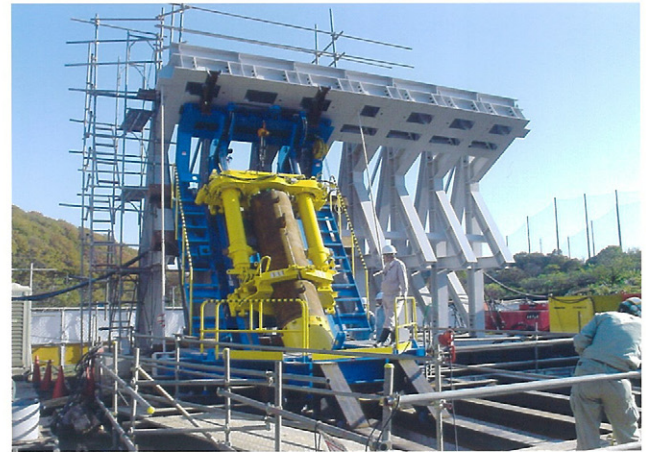
写真-1 実験装置全景
