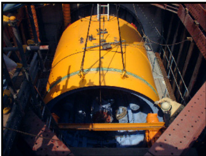
⑦ 短管投入・組立
