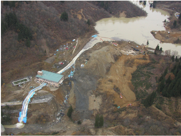
写真-7 排水ルート切替後の排水状況
