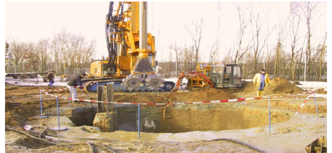
写真-3：円形立坑施工状況
