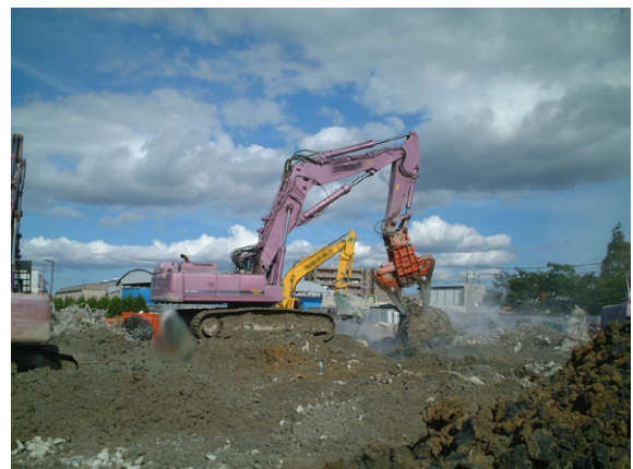
図-6：セパレートブーム解体機による基礎構造物の解体作業
