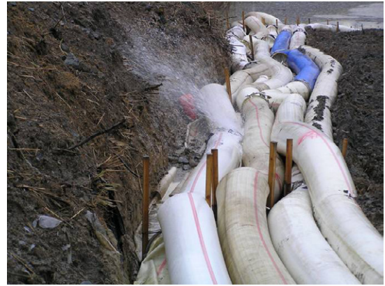
写真-3 緊急排水路に設置されたφ400mm6本のホース
