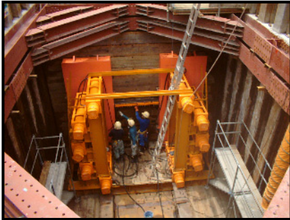
① 押し角・元押ジャッキ組立完了
