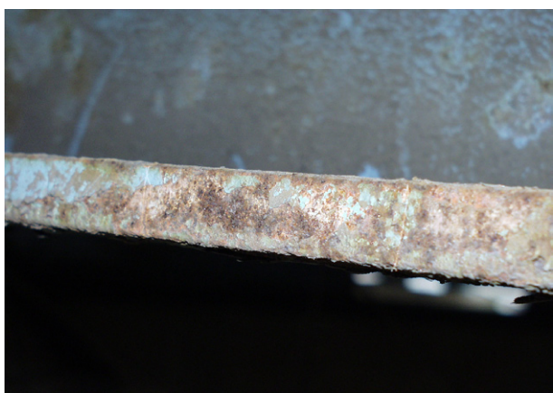
写真-1 海浜部主桁下フランジ下面 錆採取前
