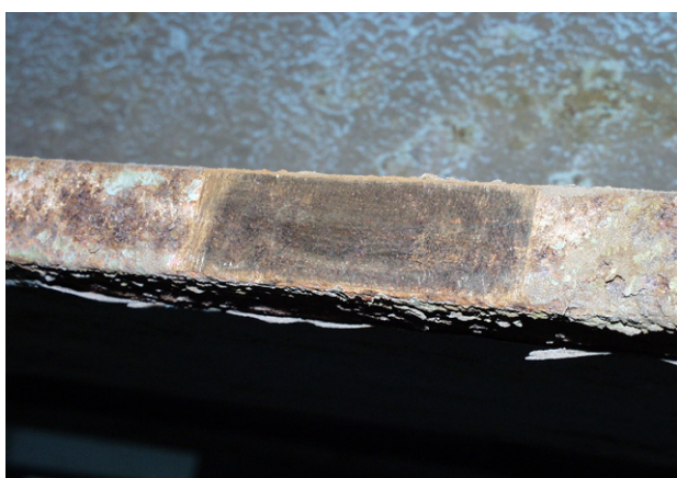
写真-2 海浜部主桁下フランジ下面 錆採取後
