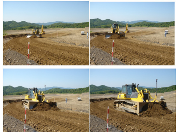
図13 テスト施工の様子
