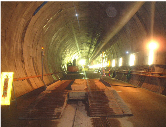
写真-5 一次覆工コンクリート打設完了
