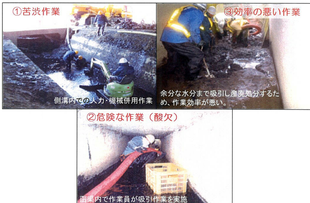
写真－1 函渠・側溝清掃作業の現状
