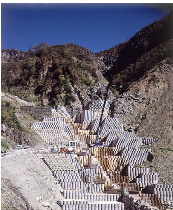
写真1 無人クレーンの作業状況
