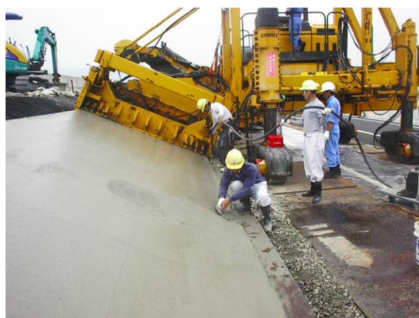
写真-4 岩国工事の端部仕上げ状況
