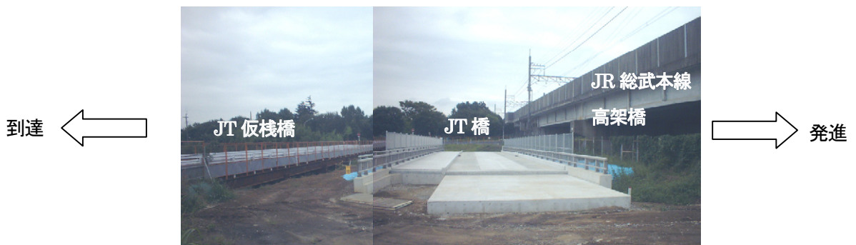
写真-1 JR 総武本線高架橋他
