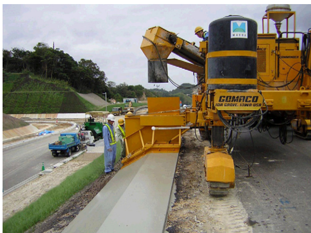
写真-1 江津工事の施工状況（盛土部）
