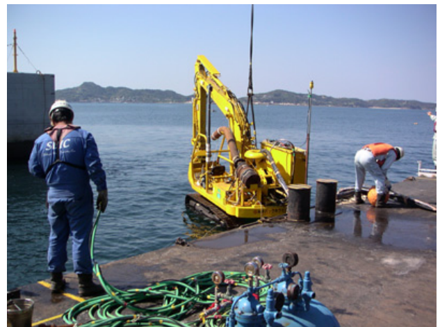
Fig.11 バックホウ投入状況
