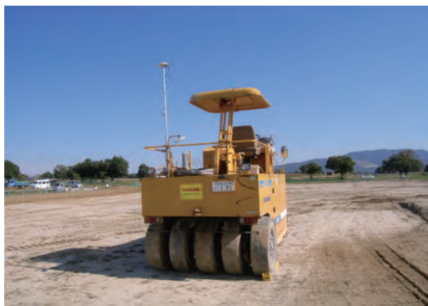
写真-9 タイヤローラによる施工
