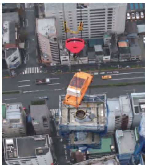
写真-3 柱建方状況
