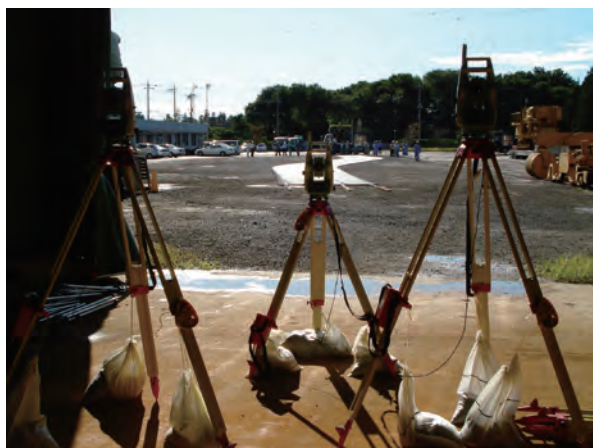
写真-3 TS 設置状況
