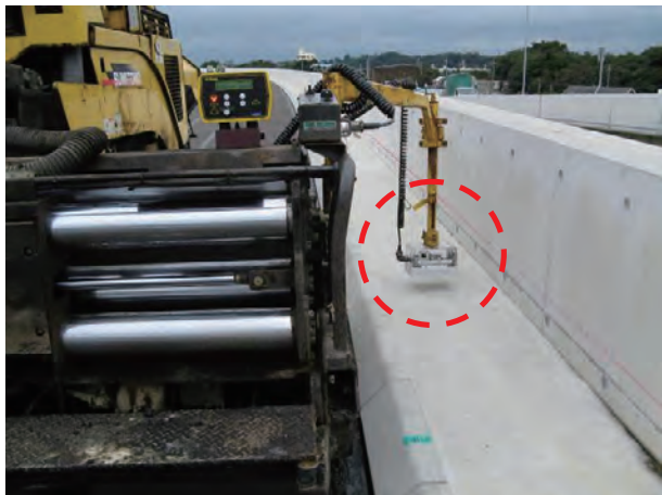
写真-10 試作機を用いた施工（沖縄県）
