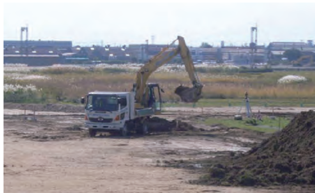
写真-7 3D-MGバックホウによる掘削
