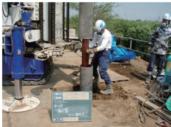
写真-6 施工状況 (2)
