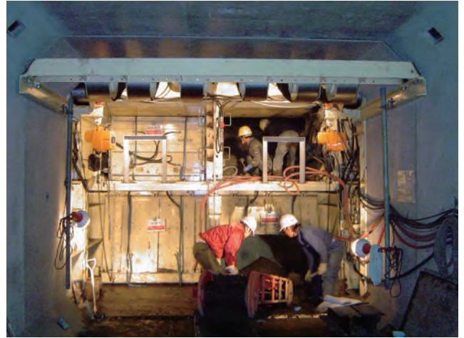
写真-4 掘削状況
