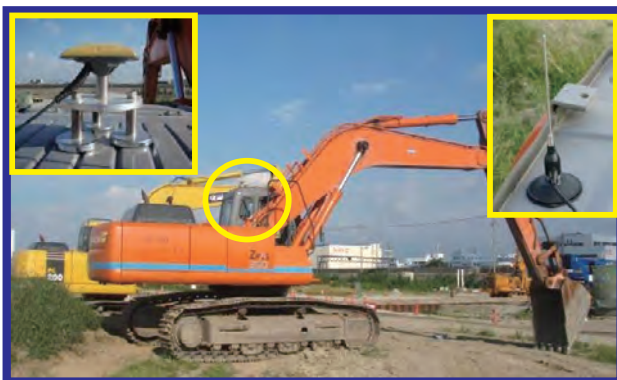
写真-3 掘削機械に搭載した GPS
