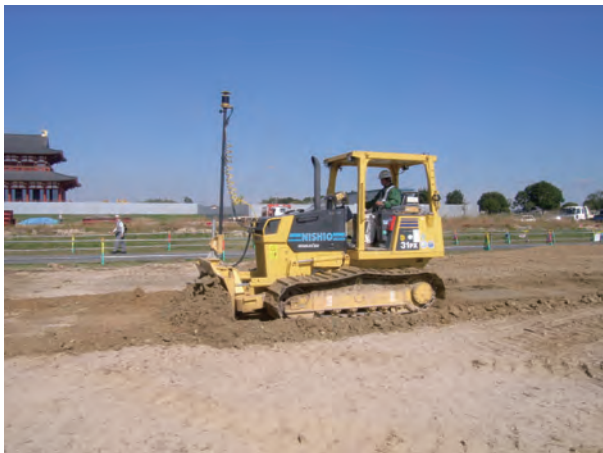
写真-5 3D-MCブルドーザーによる造成
