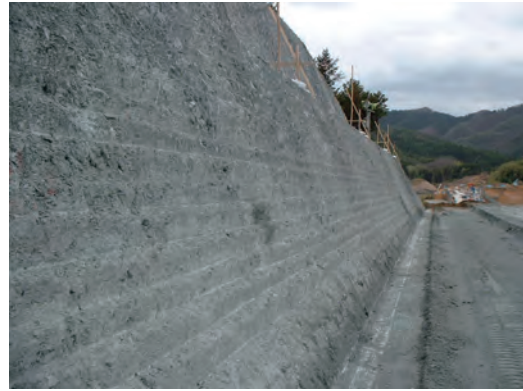
写真-4 掘削後の法面の状況
