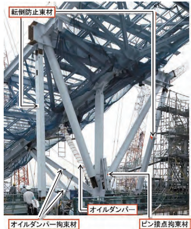
写真-8 トラス支持拘束材詳細
