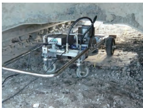
写真2 下部走行体と支持地盤の間に設置された現場支持力試験装置
