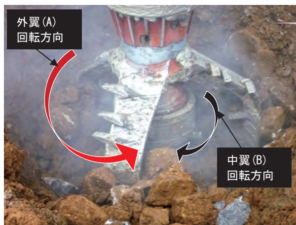
写真-5 転石混在層攪拌状況
