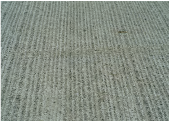
写真-3 掘削面の状況
