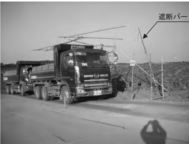
写真-2 シート掛け後、バーを開ける
