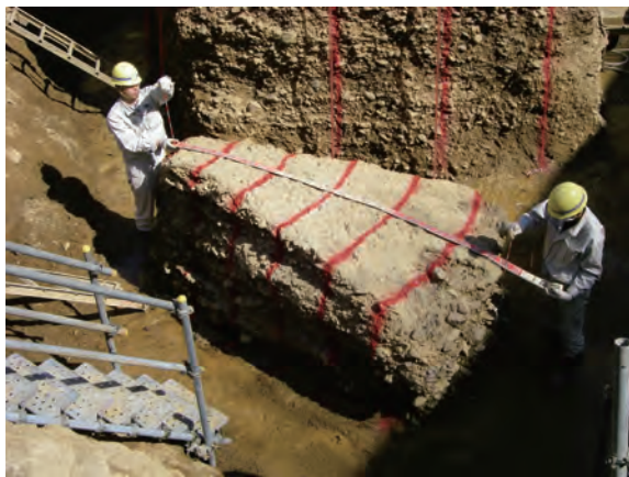
写真-3 扇形改良体(砂礫地盤)
