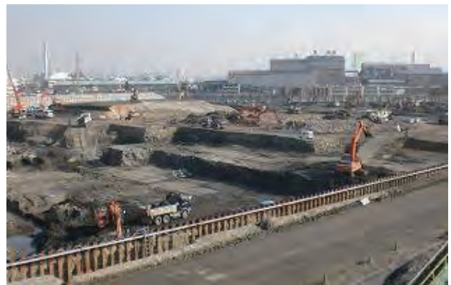
写真-1 掘削状況
