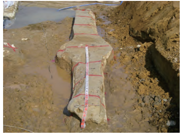
写真-4 壁状改良体(砂地盤)
