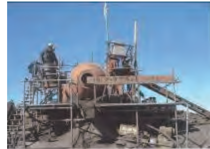
パワーショベルとコンクリートプラント
