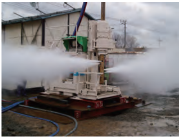
写真-8 気中噴射状況
