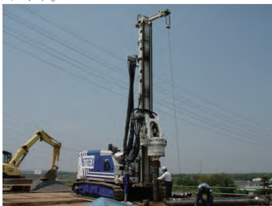
写真-5 施工状況 (1)
