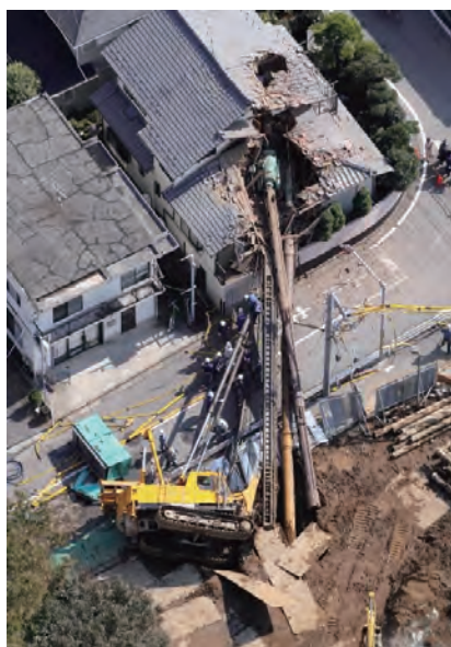
写真1 建設機械の転倒事故
