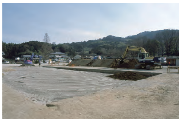
写真－3 保護砂の撒き出し状況
