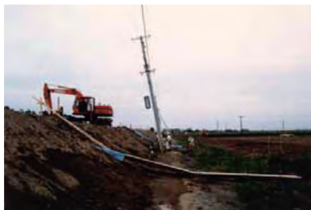
写真-1 盛土に伴う側方変位被害
