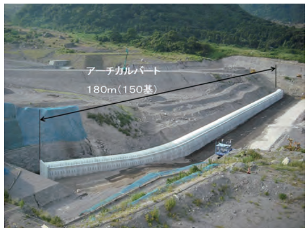
図-20 据付完了全景
