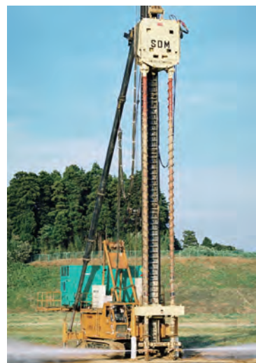
写真-1 SDM-Dy 二軸式施工機の噴射状況
