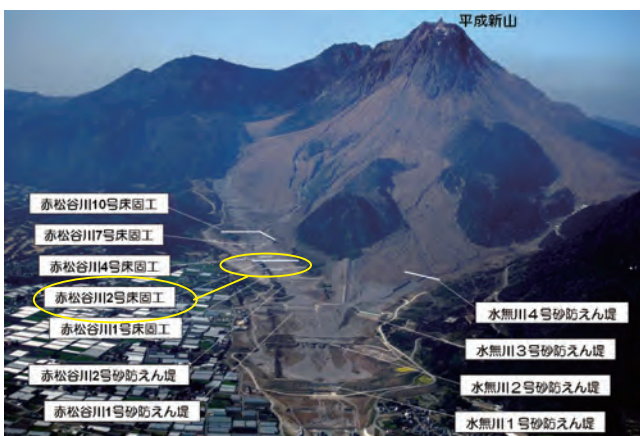
図-1 雲仙普賢岳と赤松谷川2号床固工工事位置
