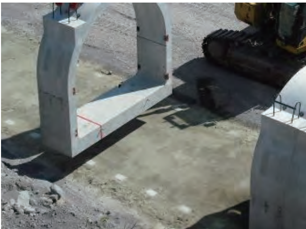
図-17 敷き砂施工による基礎部の不陸除去状況
