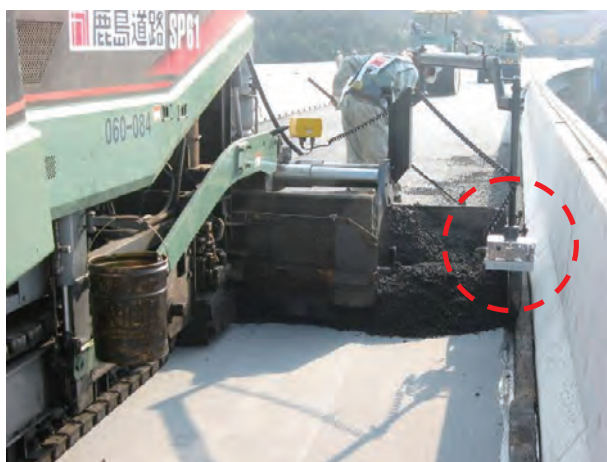
写真-9 試作機を用いた施工（鹿児島県）
