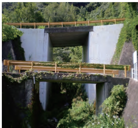
写真-4 調査対象現場
