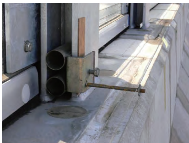
写真-4 センサワイヤ固定用脚
