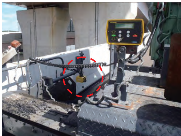
写真-13 実用モデルを使用した施工（愛知県）
