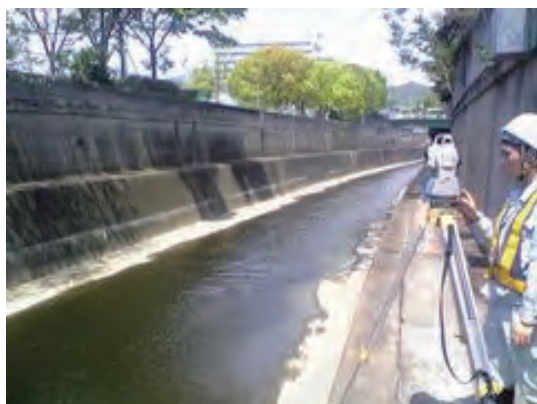
写真-3 擁壁の計測状況
