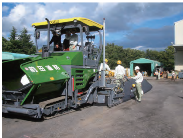
写真-4 試験施工状況
