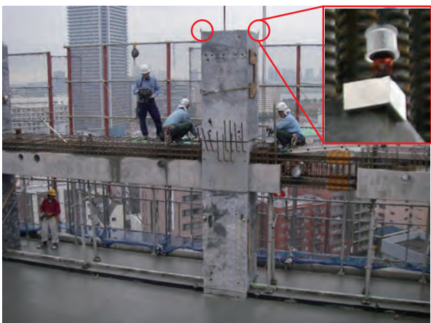
写真-4 3次元計測システムによる計測作業
