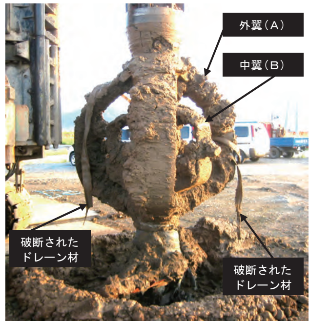
写真-4 ドレーン材破断状況
