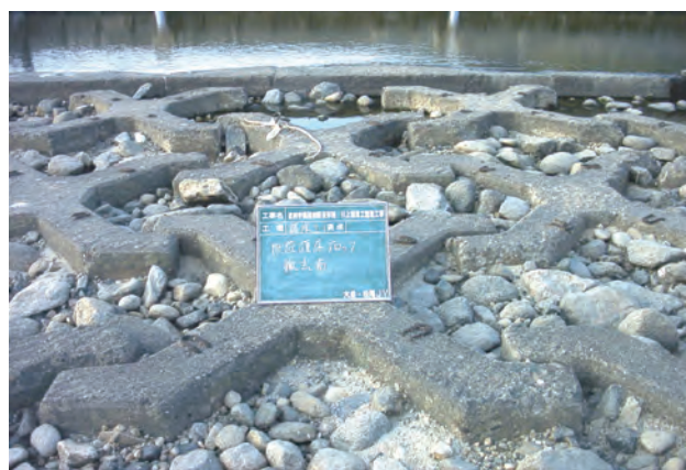
写真-1 護床ブロック
