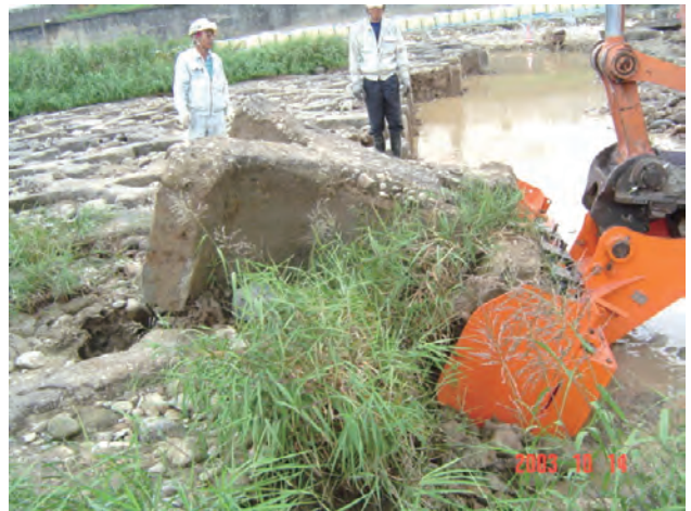
写真-2 掘り起こし作業
