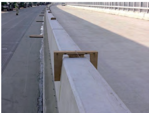
写真-3 センサワイヤ設置台
