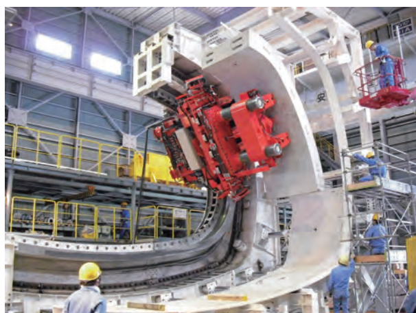
写真-3 セグメント組立状況
