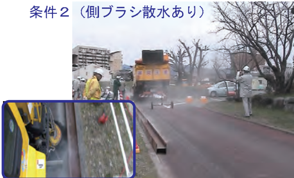
写真-1 調査状況
