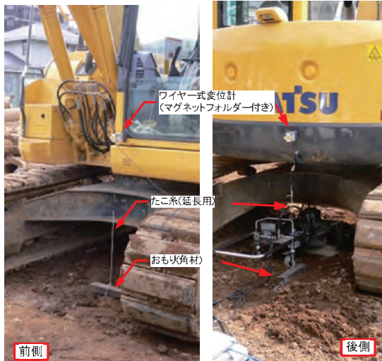
写真3 機体の浮き上がり変位量の測定 (左：前部の様子、右：後部の様子)
