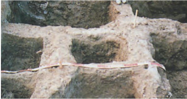
写真-1 格子状改良体(粘性土地盤)
