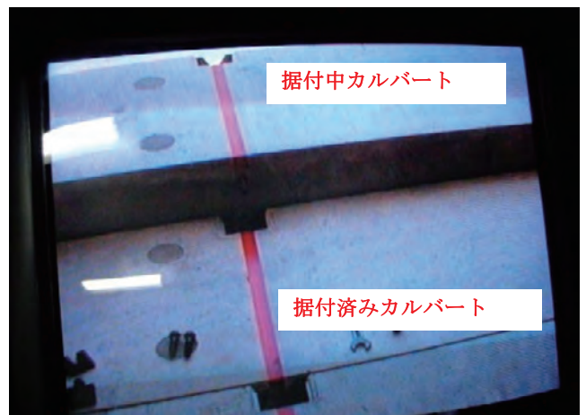
図-11 プレキャストアーチカルバート内部の監視状況
