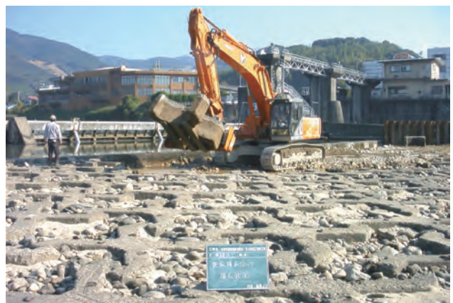
写真-3 持ち上げ作業
