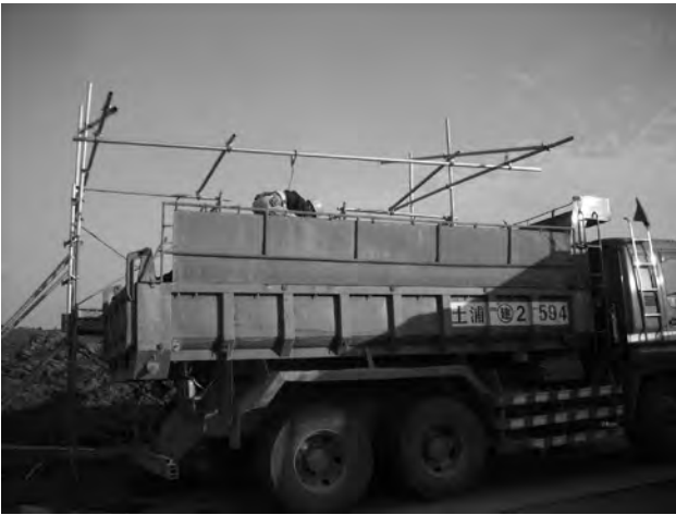
写真-1 ダンプシート掛け状況
