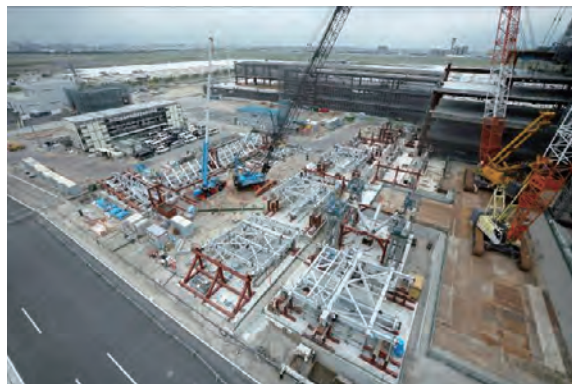
写真-2 地組ヤード
