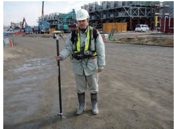
写真-5 工事測量に利用した GPS
