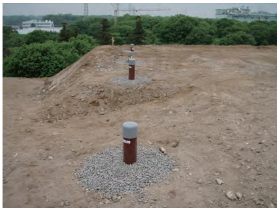
写真-7 井戸設置完了
