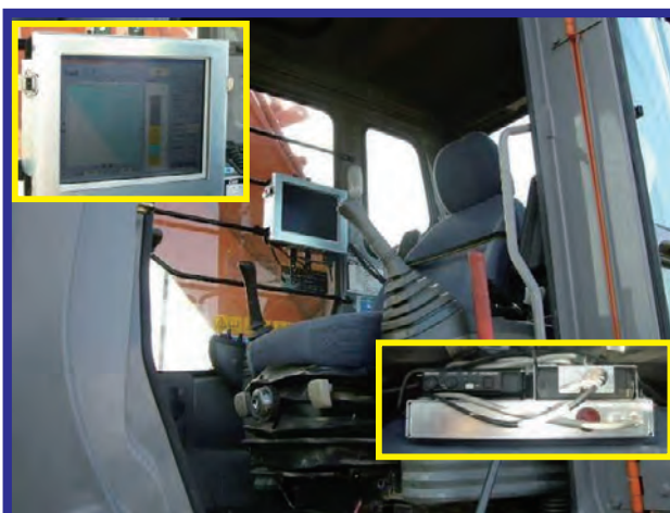
写真-4 掘削機械操作室の状況
