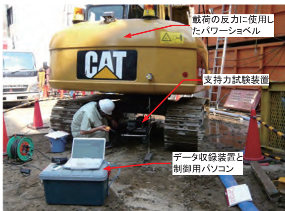
写真4 重機を反力とした支持力試験の様子
