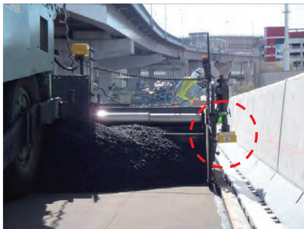
写真-12 実用モデルを使用した施工（愛知県）
