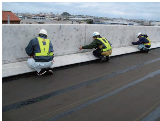
写真-5 ライン打ち作業
