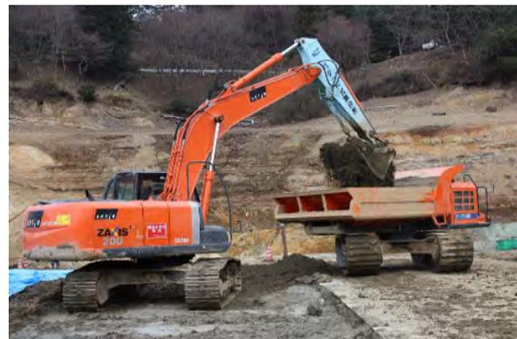
写真-4 初期固化土の解砕・積込状況
