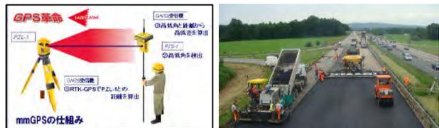
図-4 mmGPS 高精度かつ複数重機と測量の併用が可能。
