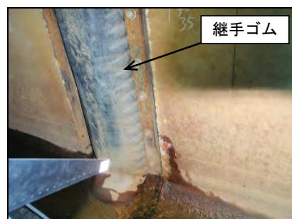
写真-12 函体継手ゴムの変形で生じた段差 (H=120mm)
