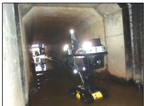
写真-8 樋門函体内 (H=1.5m) 計測状況
