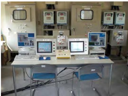
写真-6 CSG 製造総合監視システム
