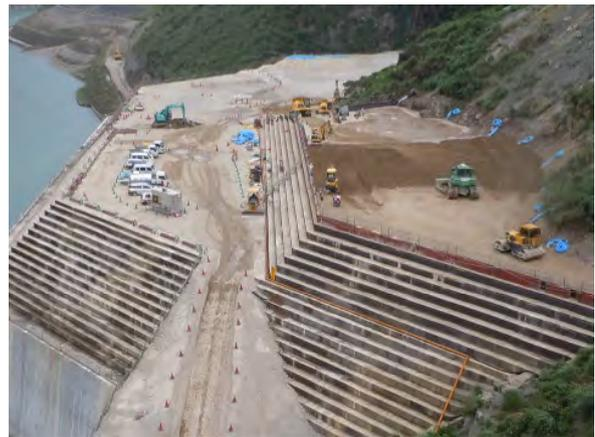
写真-11 CSG盛土 施工状況
