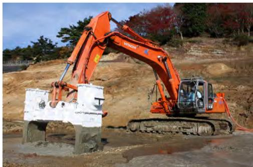
写真-2 DAM機による初期固化状況
