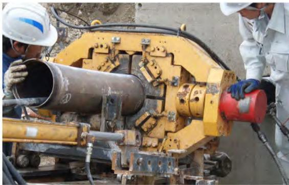
写真-3 圧着による曲線鋼管の接続
