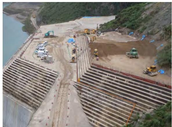
写真-11 CSG 盛土 施工状況
