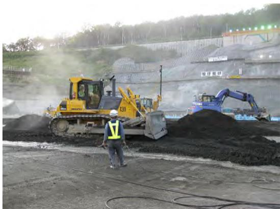
写真-8 3D-MCブルドーザ施工状況
