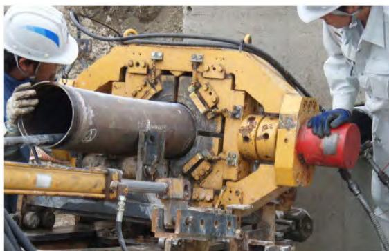
写真-3 圧着による曲線钢管の接続
