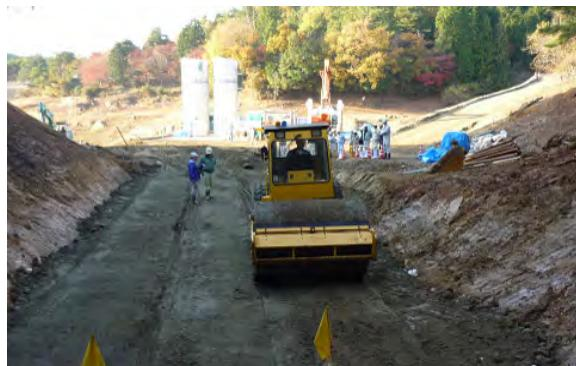
写真-6 振動ローラによる転圧状況
