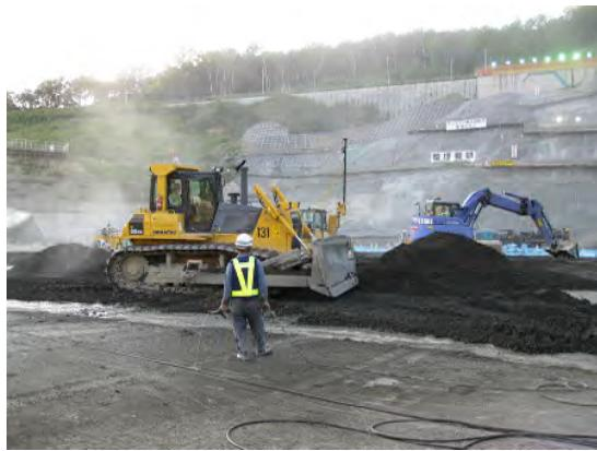
写真-8 3D-MCブルドーザ施工状況
