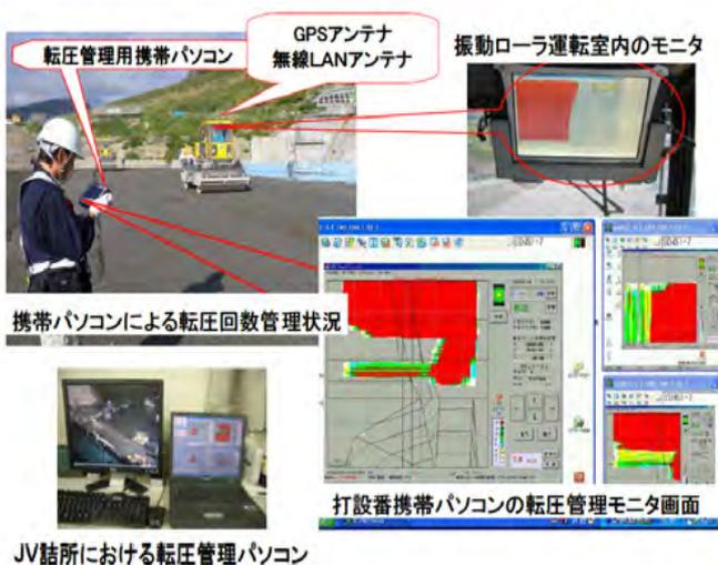
写真-9 施工管理者モニタシステム
