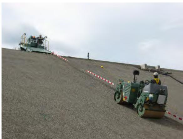
写真 - 4 施工現場（フェーシング工事）
