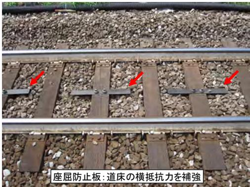
写真-1 レール張り出し対策例<sup>1)</sup>
