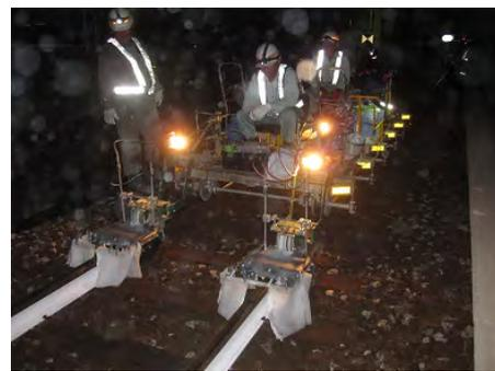
写真-8 塗布機による施工状況
