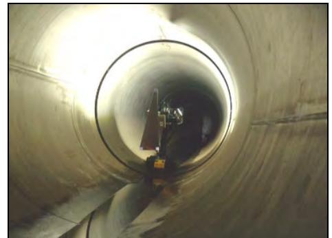
写真-9 樋管函体内 (内径 1.6m) 計測状況
