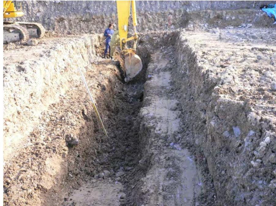
バックホーによる掘削実験の様子
