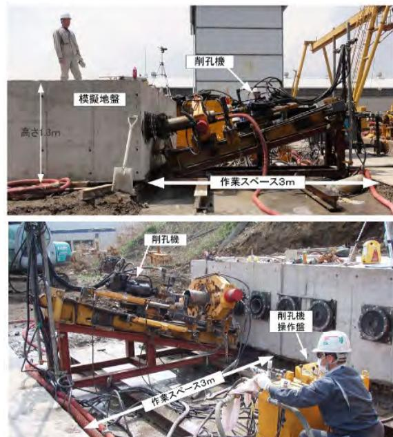
写真-2 削孔作業の状況
