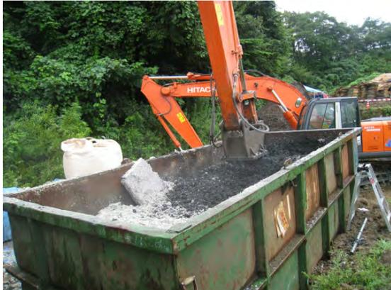
図-5 古紙破砕物を攪拌・混合
