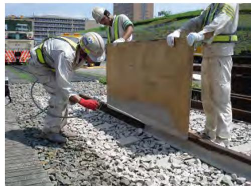
写真-3 人力による塗布施工例
