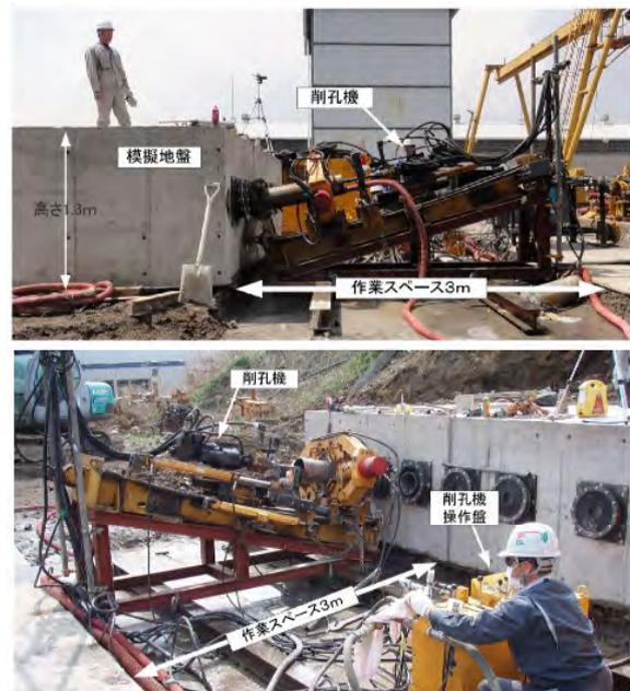
写真-2 削孔作業の状況
