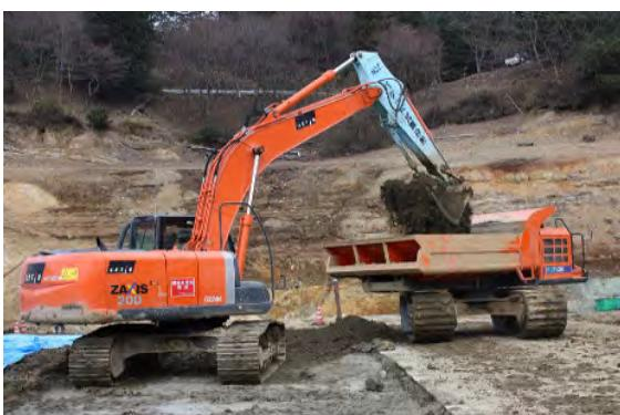
写真-4 初期固化土の解碎・積込み状況
