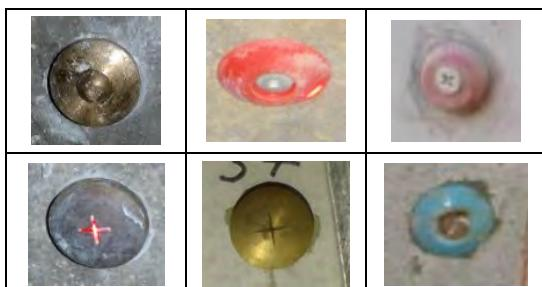
写真-14 実樋門に設置されている測定鉢
