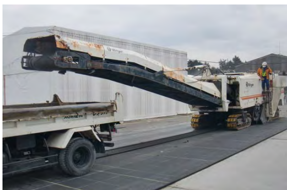
写真-11 大型切削機
