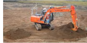
写真-3 掘削盛替実験実施状況
