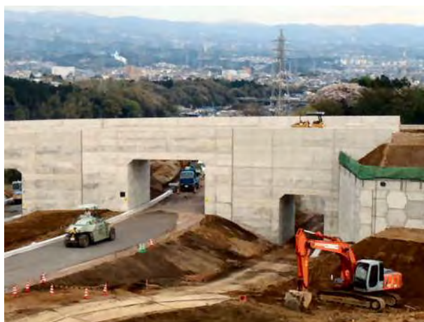
写真 - 5 施工現場（高速道路ジャンクション）
