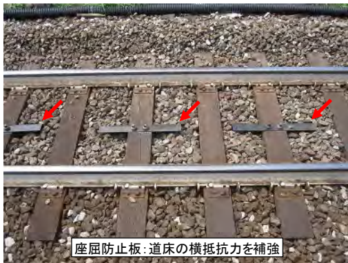
写真-1 レール張り出し対策例 1)
