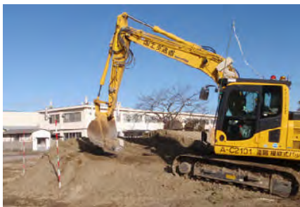
写真-4 進入路造成試験実施状況
