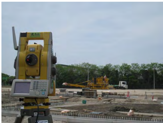
写真-3 情報化施工を適用した施工事例
