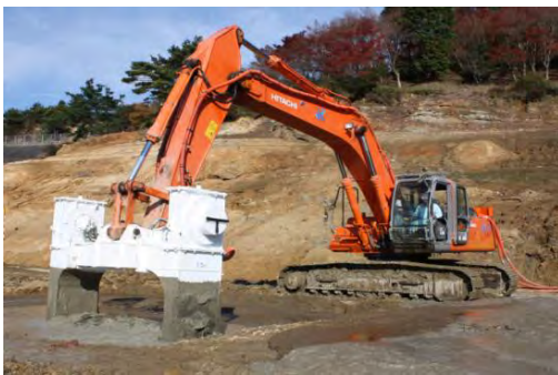
写真-2 DAM 機による初期固化状況
