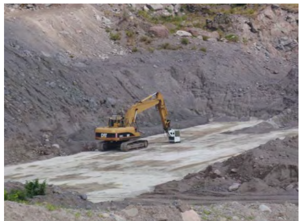
写真-7 施工状況
