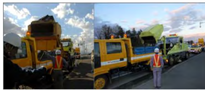
写真-5 積み込み作業の状況(比較)
