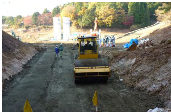
写真-6 振動ローラによる転圧状況
