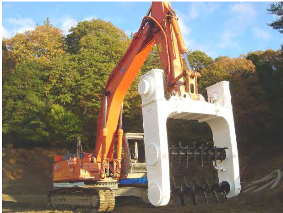
写真-8 DAM 機取付状況
