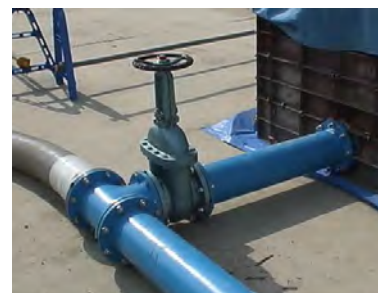
図-3 「開閉装置を備えた注水口合流部材」
