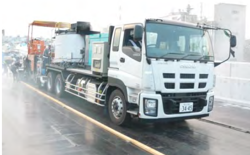
写真-6 施工状況
