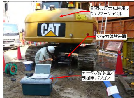
写真2 重機を反力とした支持力試験の様子
