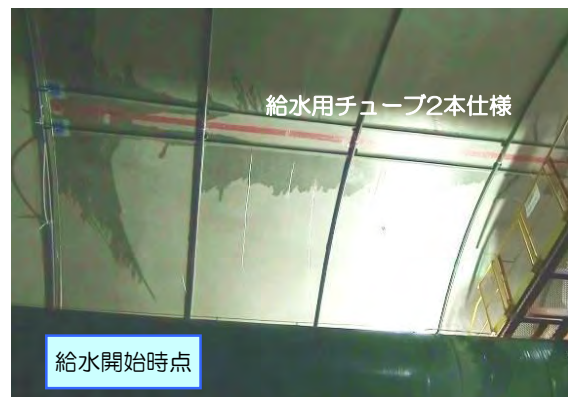
写真-6 トンネルでの水膜形成状況（給水開始）
