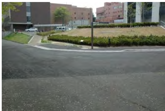
写真-6 測点 10R 付近から測点 10L 方向を望む
