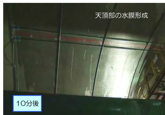
写真-7 トンネルでの水膜形成状況（10分後）
