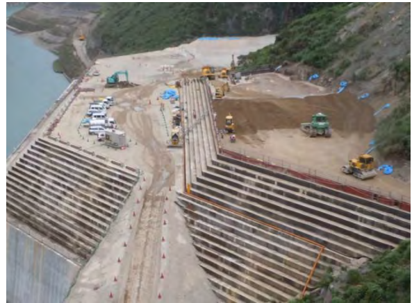
写真-11 CSG盛土 施工状況
