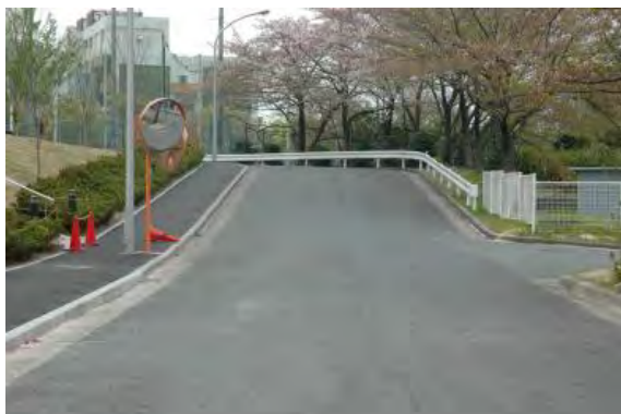
写真-7 測点 No. 12 付近から終点方向を望む
