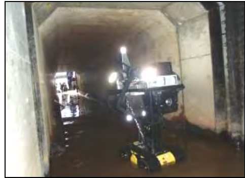
写真-8 樋門函体内 (H=1.5m) 計測状況 (遠くに見えるのが函体外の TS)
