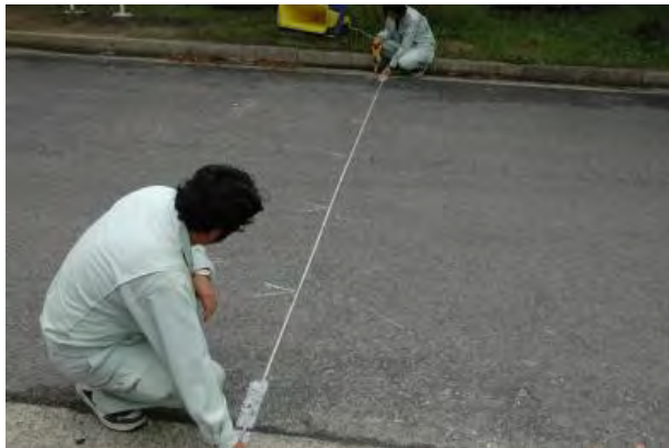
写真-8 1m毎の測点の設置状況 (白ペイントが見える)
