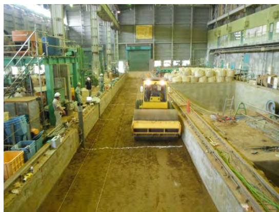
写真-4. 締固め回数試験状況
