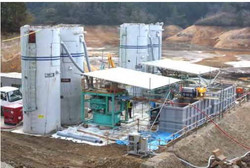
写真-1 固化材スラリープラント (2組)
