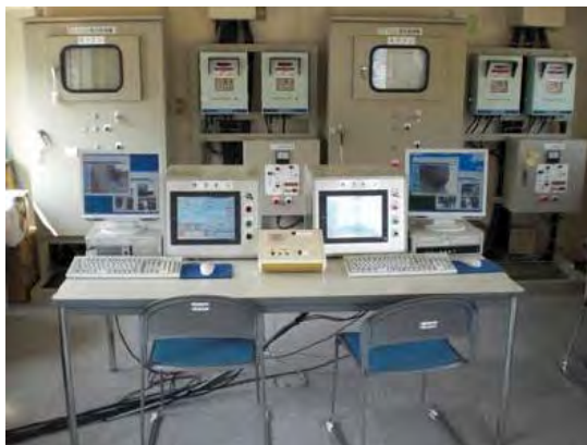
写真-6 CSG製造総合監視システム
