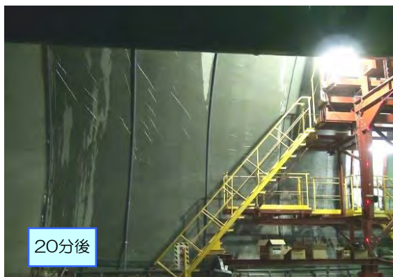
写真-8 トンネルでの水膜形成状況（20分後）
