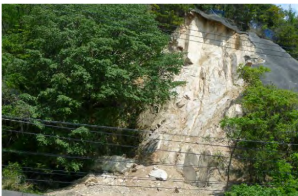
写真-2 坂町小屋浦地区災害状況
