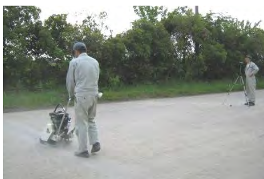
写真-3 測定状況
