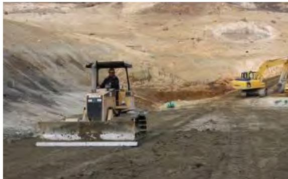
写真-5 解砕土の敷均し状況
