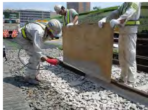
写真-3 人力による塗布施工例
