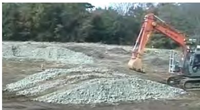
写真-2 複数回実験後の走行障害物
