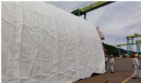
写真-3 模擬試験後の防水シート展張状況
