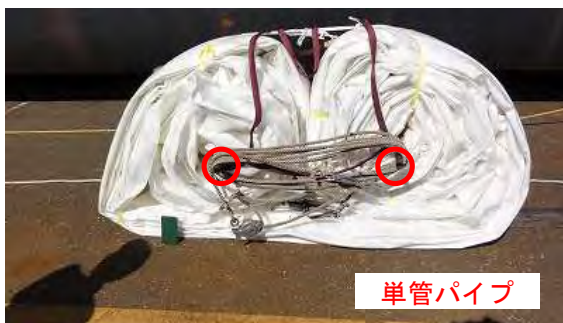
写真-4 防水シート搬入時の形状
