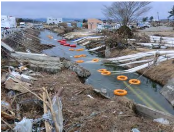
排水作業状況（宮城県名取市）
