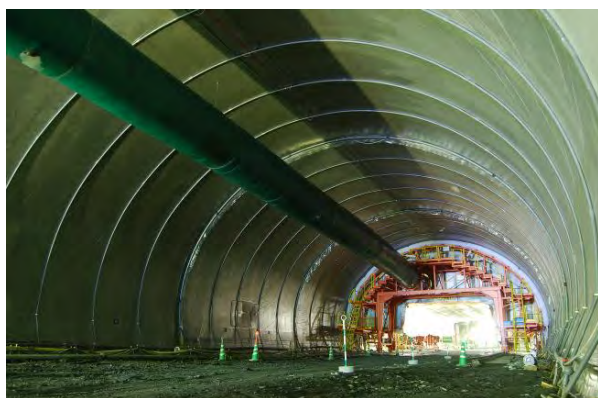
写真-10 浸水養生シート展張完了状況
