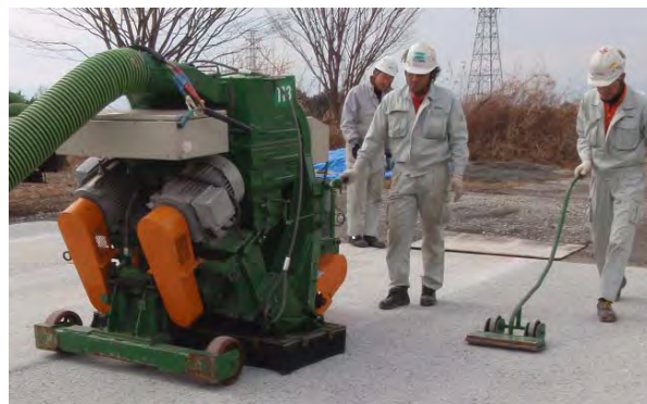
写真-13 スチールショットブラストによる表面処理
