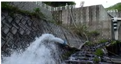
図-7 サイフォンによる排水状況
