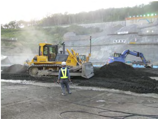
写真-8 3D-MCブルドーザ施工状況
