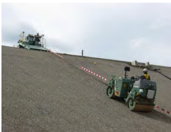
写真 - 4 施工現場（フェーシング工事）
