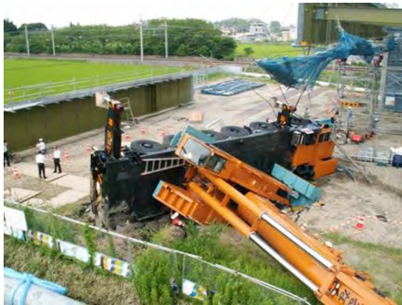
写真1 移動式クレーンの転倒事故
