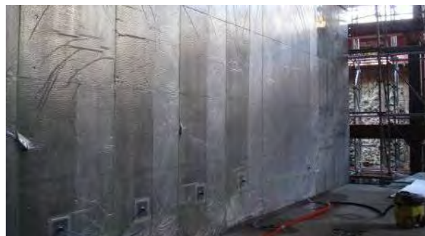
写真-12 ボックスカルバート工事の例
