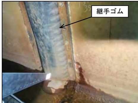
写真-14 函体継手ゴムの変形で生じた段差 (H=120mm)
