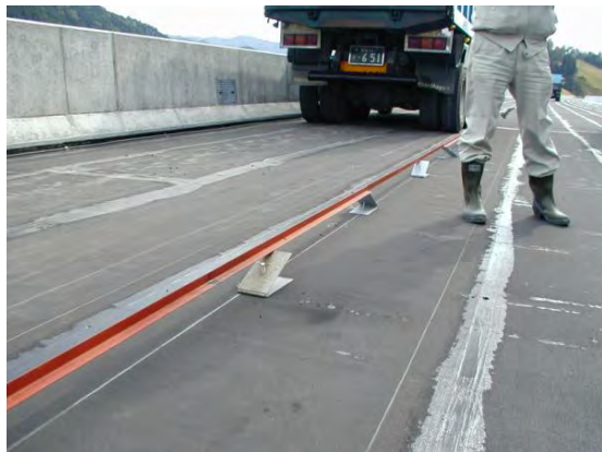
写真－1 アンクルによる複数レーンの施工状況
