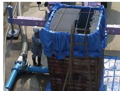
図-2 型枠用部材で組上げた仮設タンク
