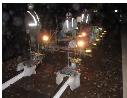
写真-7 塗布機による施工状況
