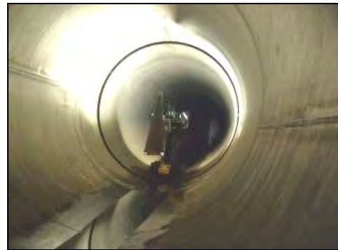
写真-9 樋管函体内 (内径 1.6m) 計測状況
