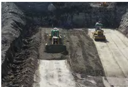
写真-1 赤松谷川6号床固工コンクリート打設状況
