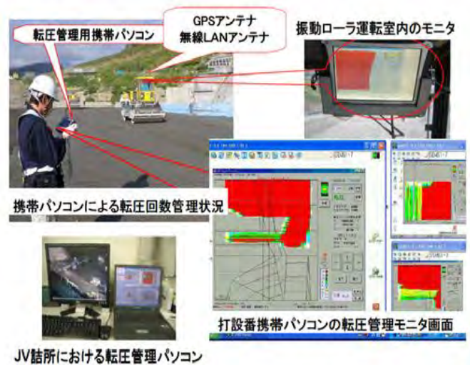
写真-9 施工管理者モニタシステム
