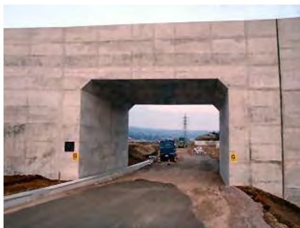
写真 - 7 橋下の施工（○印部分）
