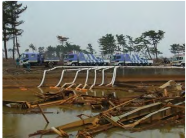
排水作業状況（宮城県仙台市若林区）
