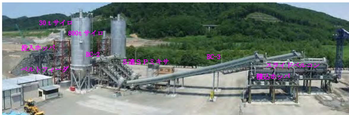
写真-5 当別ダムCSG製造設備(全景)
