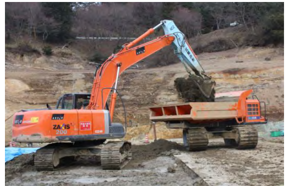
写真-4 初期固化土の解砕・積込状況
