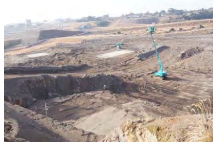
写真-2 おしが谷床固工全景
