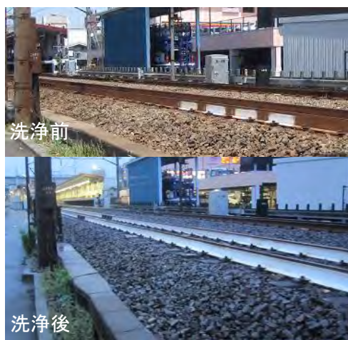
写真-10 洗浄前後の状況
