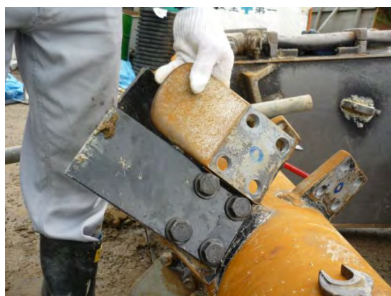
写真-9 DAM機の攪拌羽根交換状況
