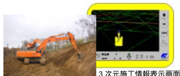
バックホウ 3次元施工状況
