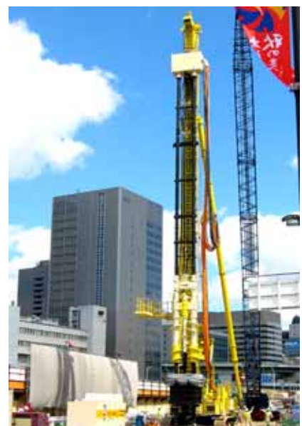
新工法施工状況
