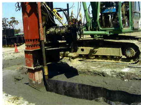
図-3 シート横引き展開状況
