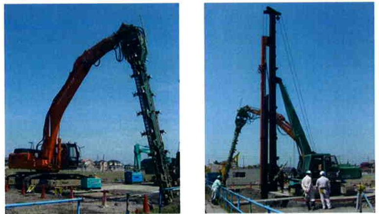
図-2 トレンチャー式地盤改良機（左）とシート展開装置（右）
