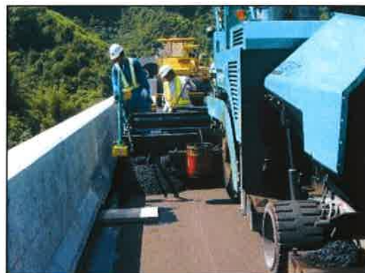
写真-2 ラインリーダによる施工状況
