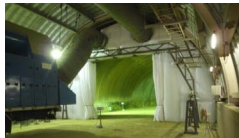
写真1 トラベルクリーンカーテン設置状況
