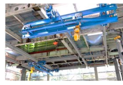
写真上：内観 写真左上：天井クレーン及びテルハ 写真左下：傾斜式スラブ切断(無支保工) 写真右：仮設支柱および自動降下システム 写真下：解体工事進捗状況
