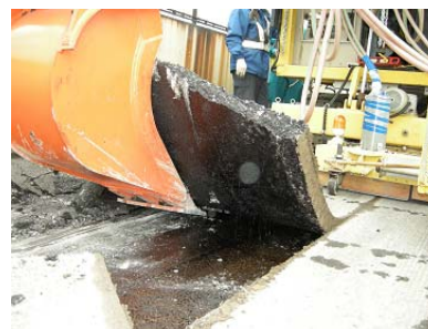
図-1 舗装はぎ取り状況
