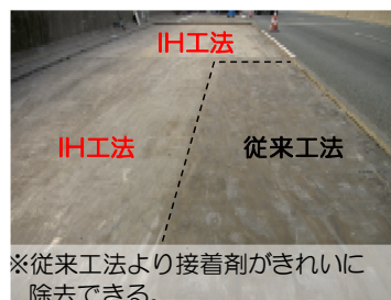
図-4 舗装撤去完了状況の比較
