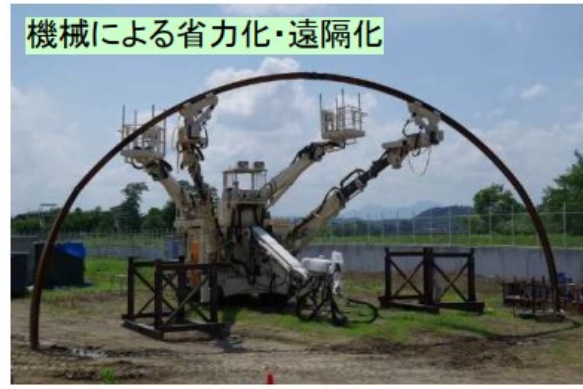
鋼アーチ支保工建込み
