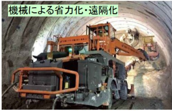
爆薬装填のための削孔
