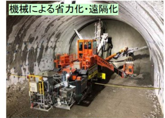
ロックボルト削孔・打設
