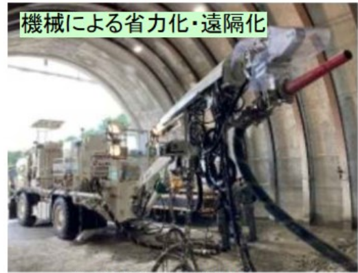
コンクリート吹付け
