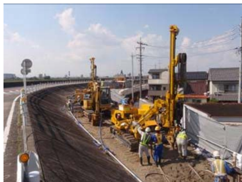
既設河川堤防上における施工状況
