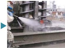
④ 造成完了⇒補正のため、ユニット毎に、引き揚げ後に1分の静止が必要
