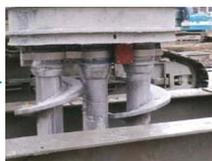
③ 削孔開始⇒補正のため、ユニット毎に、地中に入る前に1分の静止が必要
