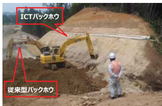
ICTと従来型の建機による施工
