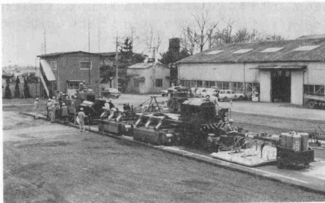
写真-1 試験施工状況
