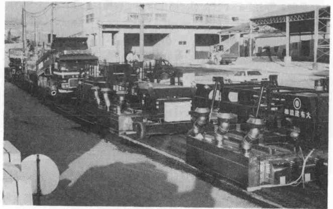
写真-1 リペーブ工法施工状況
