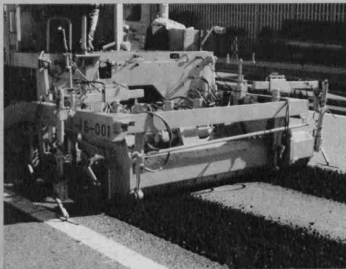
◆ 大林道路・リシェーバ (わだち掘れ部路上再生処理状況)
