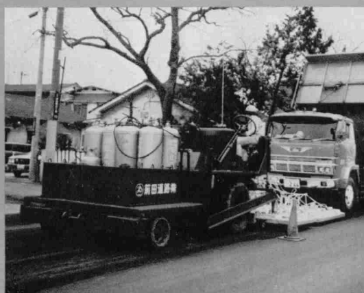
⇨ 前田道路・補助ロードヒータ
