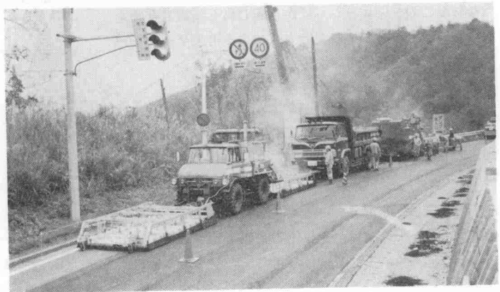
写真-1 再生サーフェース工法施工状況
