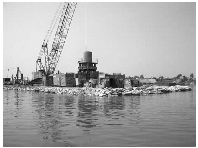
写真—1 築島による杭施工状況
