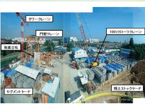
⇨12. シンガポール シールド工事 作業基地全景
