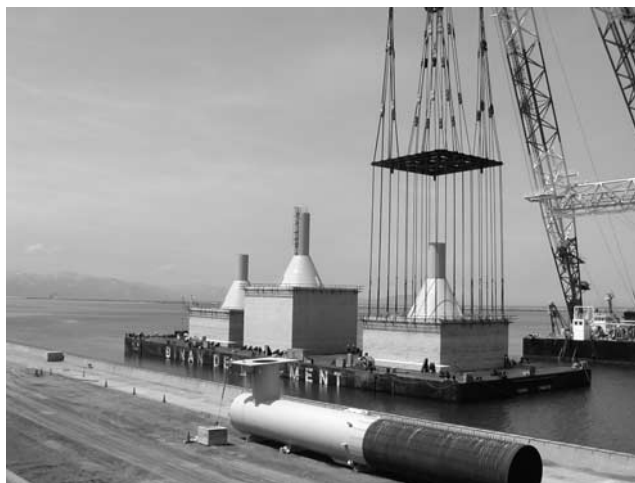
写真—4 3,000T起重機船によるケーソンの積込
