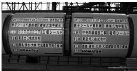
写真1 接合(貫入)状況
