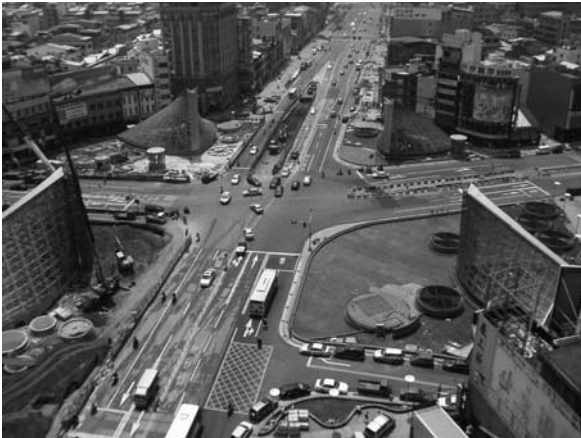
写真一 円形駅部現在施工状況
