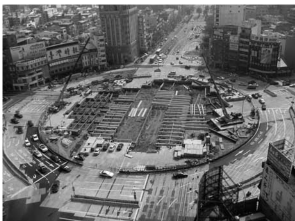
写真—5 円形駅部路面覆工状況
