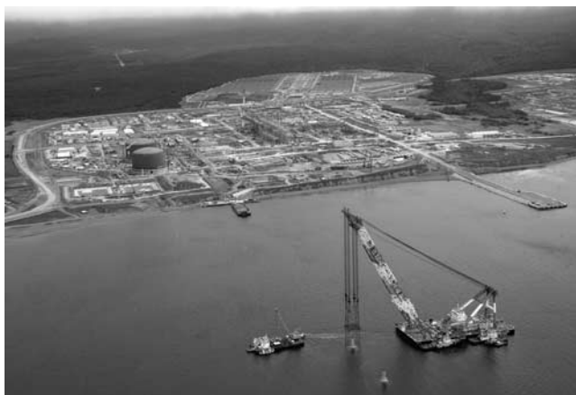
写真—6 3,000 T 起重機船によるケーソン据付
