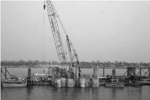
写真-3 バージを使用した杭施工状況
