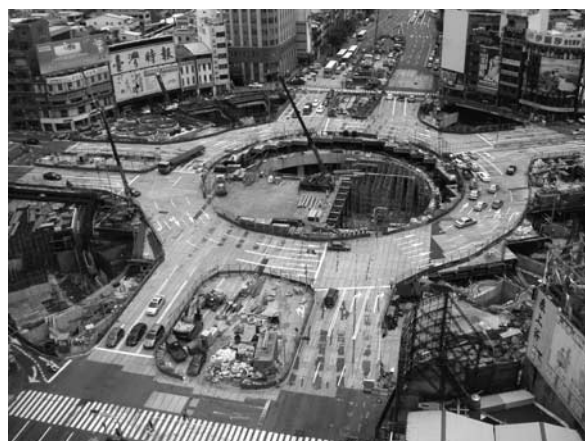
写真—7 円形駅部構築施工状況
