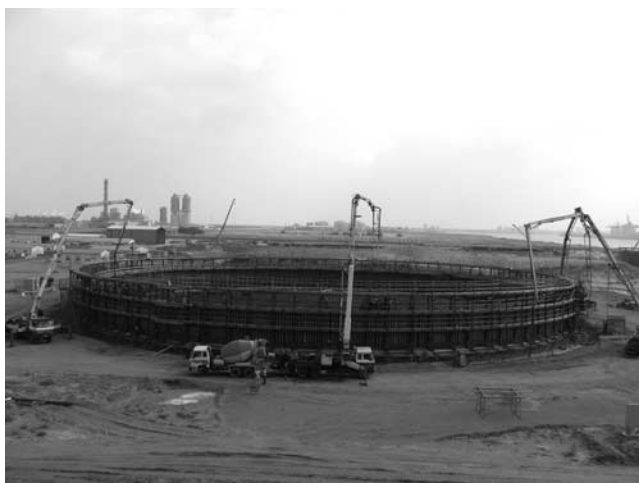
写真-4 PC防液堤コンクリート打設
