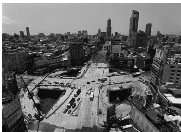
写真—6 円形駅部掘削状況
