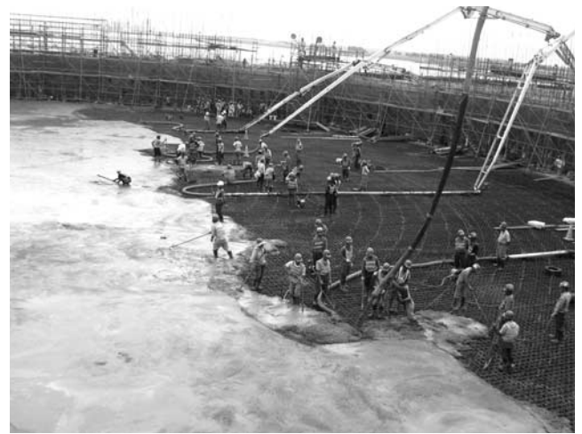
写真—3 基礎版コンクリート打設
