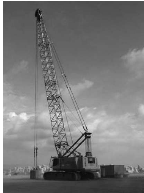
写真一 1 動圧密工法 (1)
