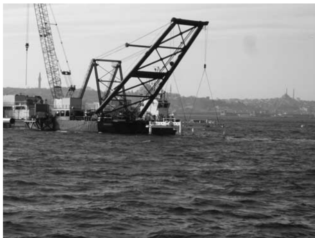
写真—3 SUG 設置状況
