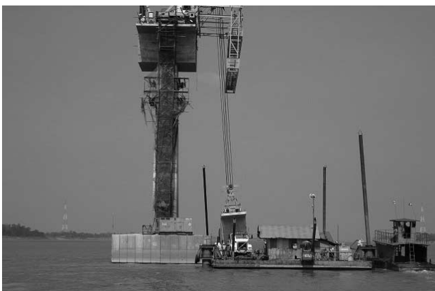
写真—6 基準セグメントの斜め吊り
