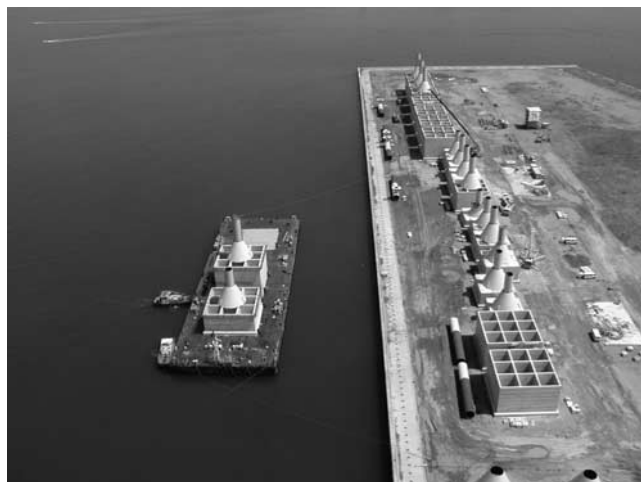
写真—2 石狩新港のケーソンヤード
