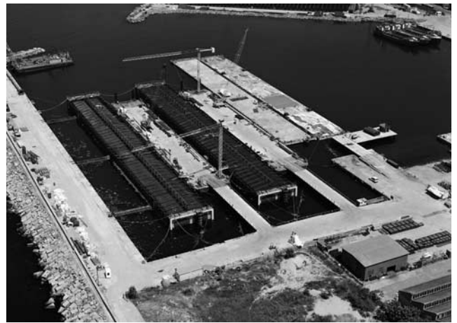
写真二 洋上係留設備での函体構築
