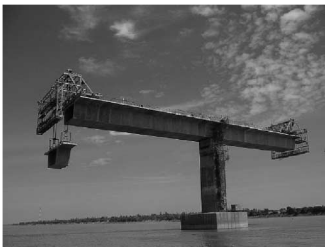
写真-4 セグメント架設状況
