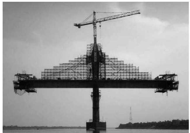
写真—8 斜版部施工状況
