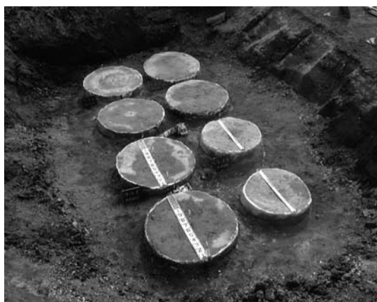
写真—4 大口径施工（手前：φ1300 mm）の改良杭頭
