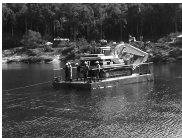
写真一7 ダムサイトのバージ
