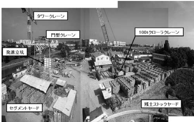
写真—8 作業基地全景
