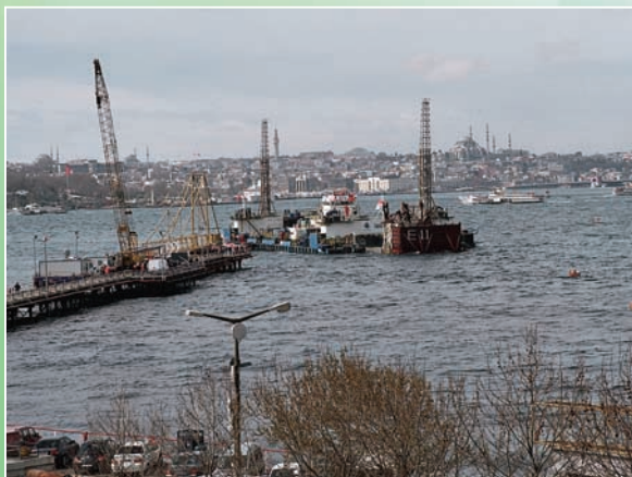
⇧ 7. 同 沈埋函沈設作業
