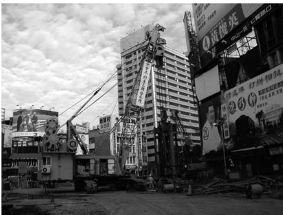
写真-2 円形連続壁 EMX 掘削機
