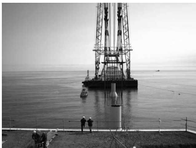
写真—7 Trestle の据付状況
