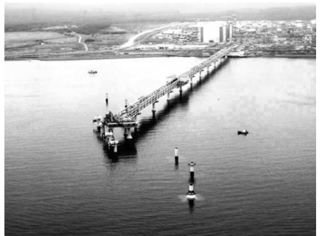
写真-1 2006年LNG栈橋とターミナル
