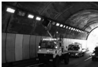
図-1 トンネル照明器具の清掃状況
