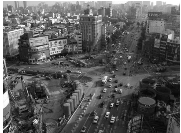
写真-3 円形連続壁施工状況
