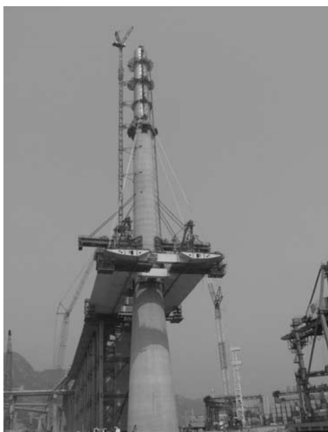
写真一 1 建設中のストーンカッターズ橋
