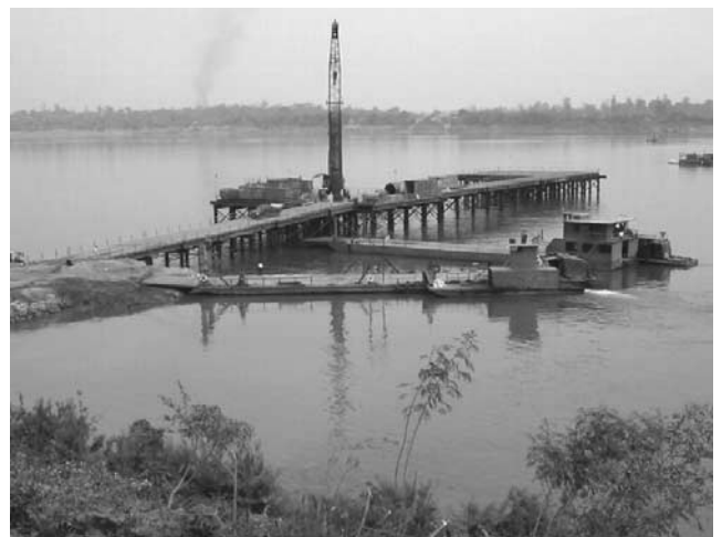
写真—2 仮設栈橋による杭施工状況
