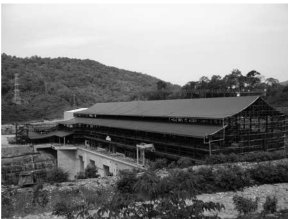
写真-2 CW2 工区 発電所建設工事
