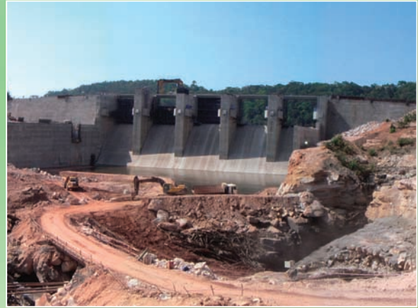
⇨9. 同 ナカイダム下流より
