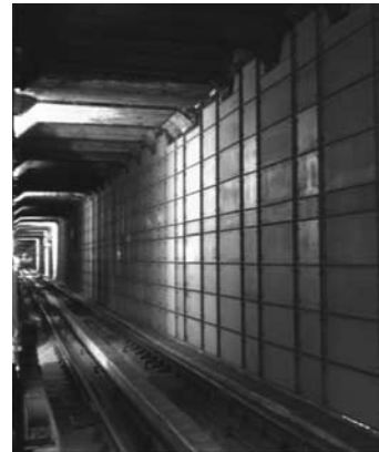
写真一 「ブロック分割除去工法」囲い込みパネル取り付け全景
