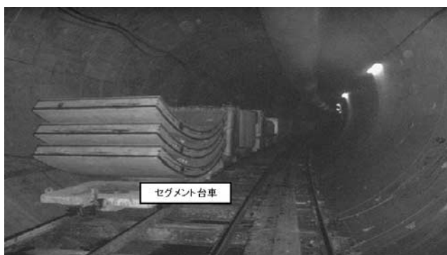
写真一七 セグメント運搬状況
