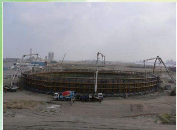
⇨15. 同 PC 防液堤コンクリート打設
