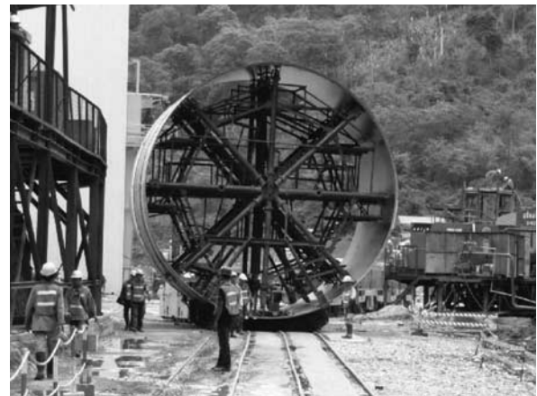
写真-3 CW2 工区 トンネル内用鉄管搬入状況
