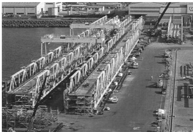
写真—3 80m 2 階建て連絡橋の製作
