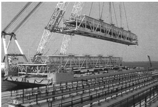
写真—5 連絡橋他の積込
