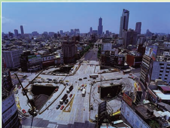
⇧ 1. 台湾高雄地下鉄工事 円形駅部掘削状況
