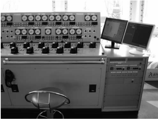
写真-8 クレーン船操船室内状況
