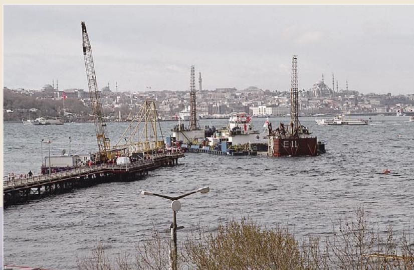
沈埋函沈設作業
