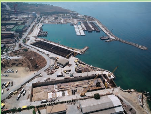
⇧ 6. トルコボスボラス海峡トンネル工事 函体製作ヤード
