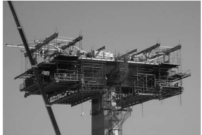
写真—7 ワーゲン施工状況
