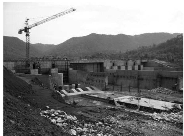
写真-4 CW3 工区 調整堰 (下流右岸より)
