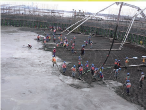
⇨14. 台湾 PCLNG タンク建設工事 基礎版コンクリート打設
