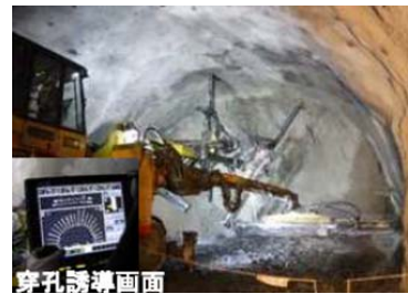
ロックボルト穿孔状況
