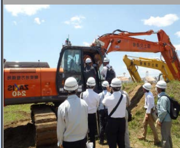
ICT建機施工体験
