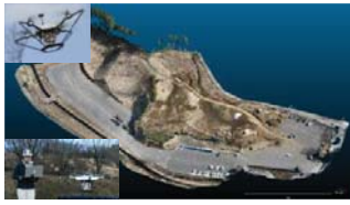
①ドローン等による3次元測量
