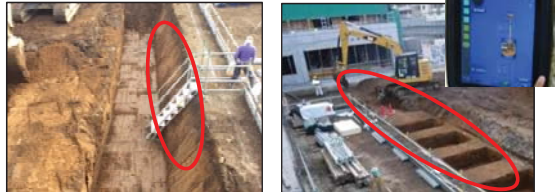
オープンカット法面整形(60°3D) つば掘 床付け(3D：2D+深さ)
