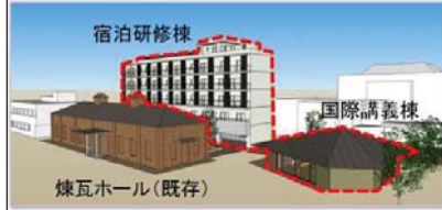
海上保安大学国際交流センター（着工済み）
