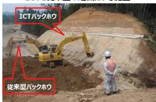
ICTと従来型の建機による施工
