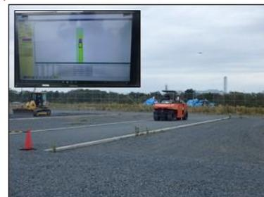
TSやGNSSを用いた締固め管理の実演
