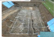
設計図に合わせた施工範囲、区割り等の測量及び目印設置
