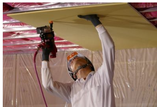
PC Watch “積水ハウスら、建築施工ロボットと上向き作業用アシスト スーツをデモ”より「通常の天井石膏ボード張り作業の様子」 ( https://pc.watch.impress.co.jp/docs/news/1127408.html )
