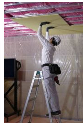
PC Watch “積水ハウスら、建築施工ロボットと上向き作業用アシスト スーツをデモ”より「通常の天井石膏ボード張り作業の様子」 ( https://pc.watch.impress.co.jp/docs/news/1127408.html )
