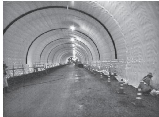
写真-3 背面平滑工法防水シート
