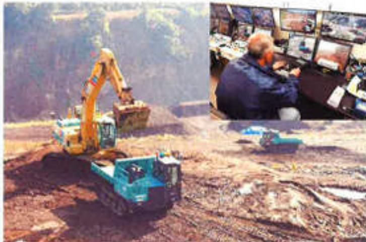
自動走行は、様々な現場環境に対応するため、オペレータが遠隔操作で最適な経路を作成し、その教示データを車載 PC に記憶させる。自動運転モード時は、車載 PC に記憶した教示経路と自車の位置とを比較し、その差を自動制御しながら、忠実に自動走行する。
