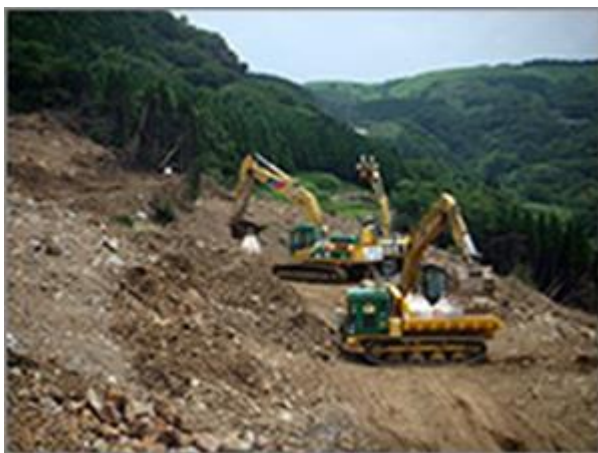
図 1 阿蘇大橋地区における無人化施工
