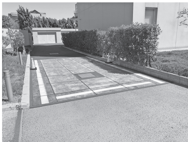
写真-1 開発した太陽光発電舗装
