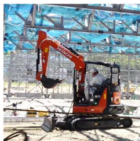
土間敷き均し
