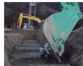
捨てコン型枠用マーキング
