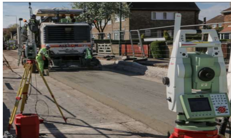
MCシステム:PS3D TS:TPS1201+ (Leica社製)
