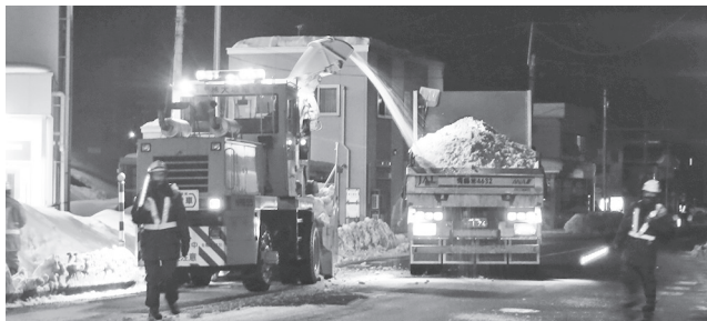
写真—1 排雪運搬作業
