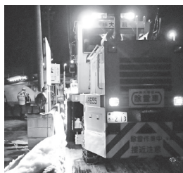
写真—3 堀ギリギリの作業
