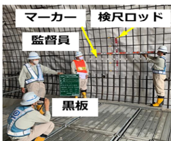
従来の配筋検査
