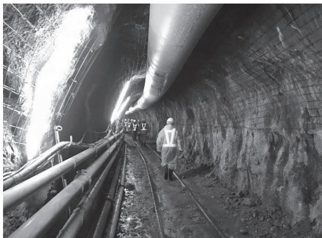
写真-8 坑内標準断面
