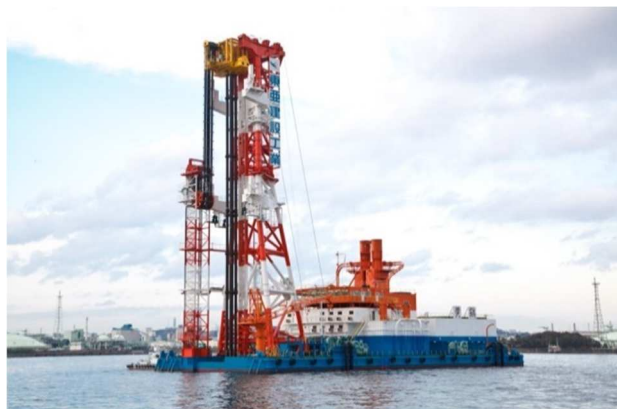
写真-1 深層混合処理船「黄鶴」
