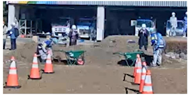
図-5 人力土工 (掘削作業と一輪車への積込み)
