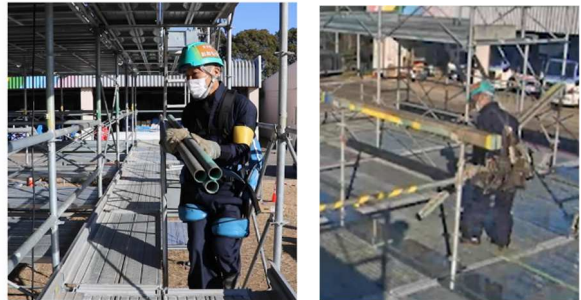
図-12 小運搬（仮設足場の昇降と中腰の潜抜け）
