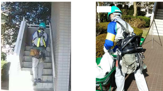
図-10 小運搬（建物階段の昇降と資材持ち上げ）
