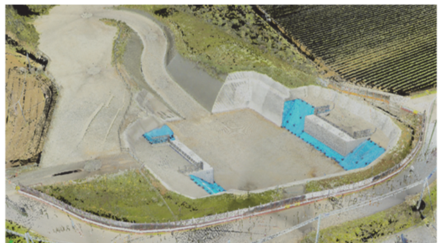
図-5 TLSによる完成時現場全体点群データ
