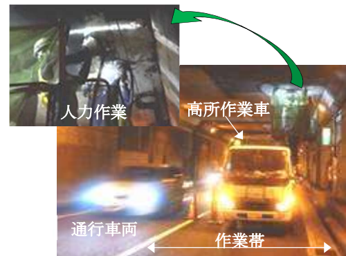
写真-1 人力によるトンネル天井面の研掃作業
