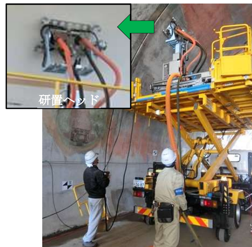
写真-8 自動化運転による研掃作業状況
