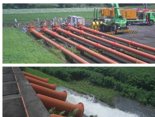
写真-1 救急排水機場外観(北海道滝川市)
