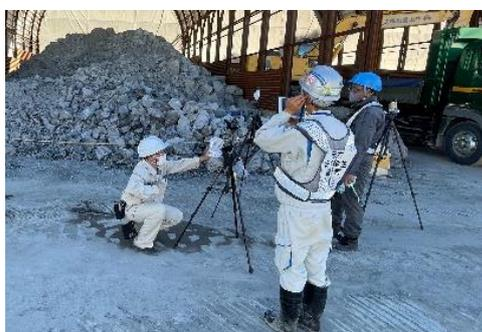
図-1 ウェアラブルカメラなど使用の遠隔臨場
