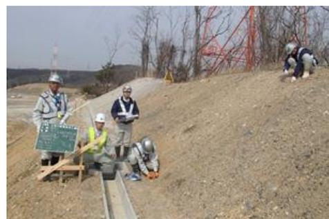
図-10 従来の法長検尺状況
