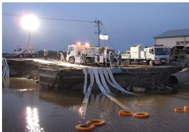
写真－2 夜間排水状況
