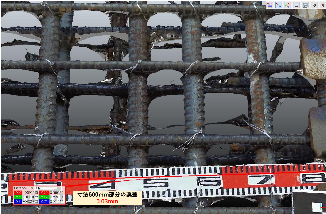
橋脚鉄筋の3次元再構築
