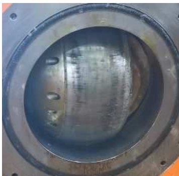
フレーム外側(掘削面)
