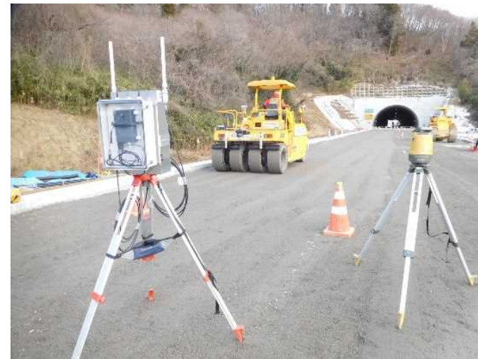
路盤工の計測状況（富沢工区①No.190付近）
