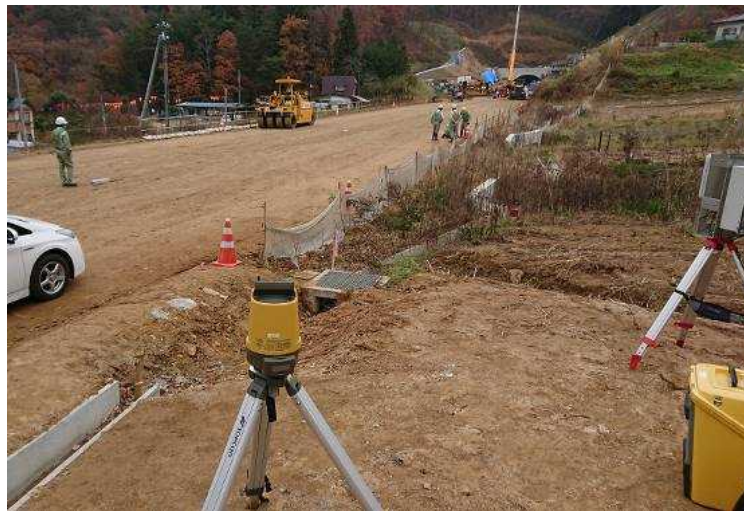
路床工の計測状況（掛田工区No.90付近）
